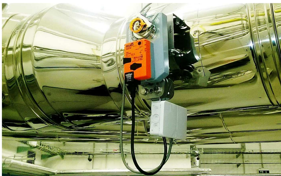
Obr. 28 Spalinová škrticí klapka se servomotorem [26]
