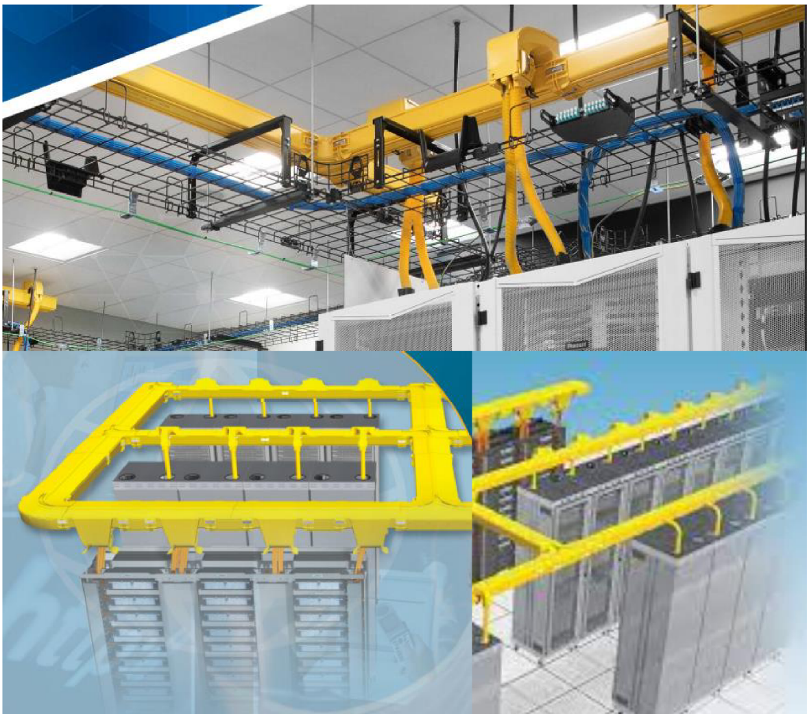
Obrázek 8 - Panduit FiberRunner® (Zdroj: 11)
