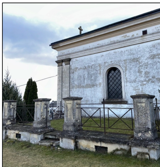
Obr. 15 Náměšť na Hané, Hrobka Kinských, 1871, pravá terasa, pohled ze severozápadu
