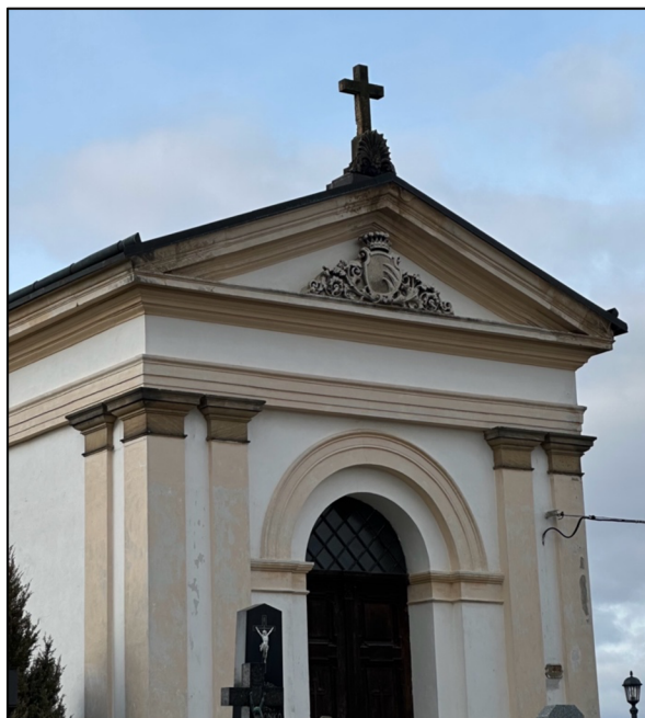
Obr. 13 Náměšť na Hané, Hrobka Kinských, 1871, detail průčelí kaple, pohled z východu
