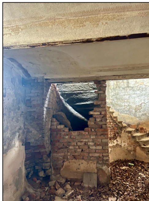
Obr. 10 Hustopeče nad Bečvou, hrobka von Baillou, Zachariáš Hermann, 1885–1887, schodiště do krypty
