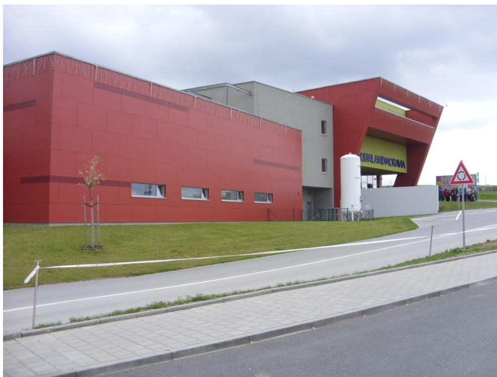
Příloha 8 Stavba Aqualandu na nalezišti římské nemocnice z 2. st. n. l. (Kolíněk)
