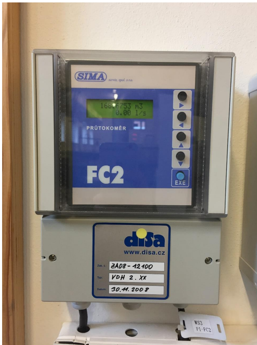
Obr. 11 Vyhodnocovací jednotka indukčního průtokoměru
