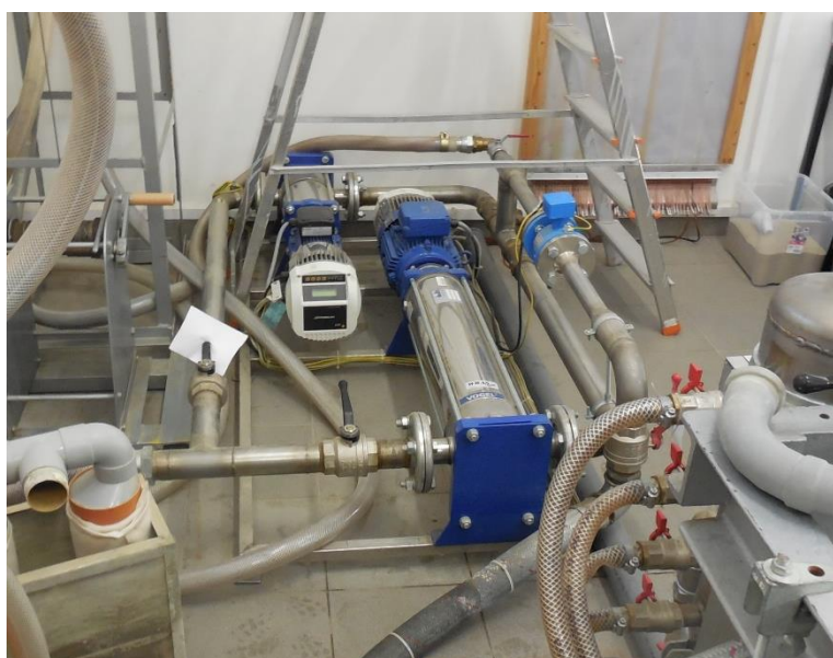
Obr. 10 Čerpací systém Vogel s regulačními jednotkami
