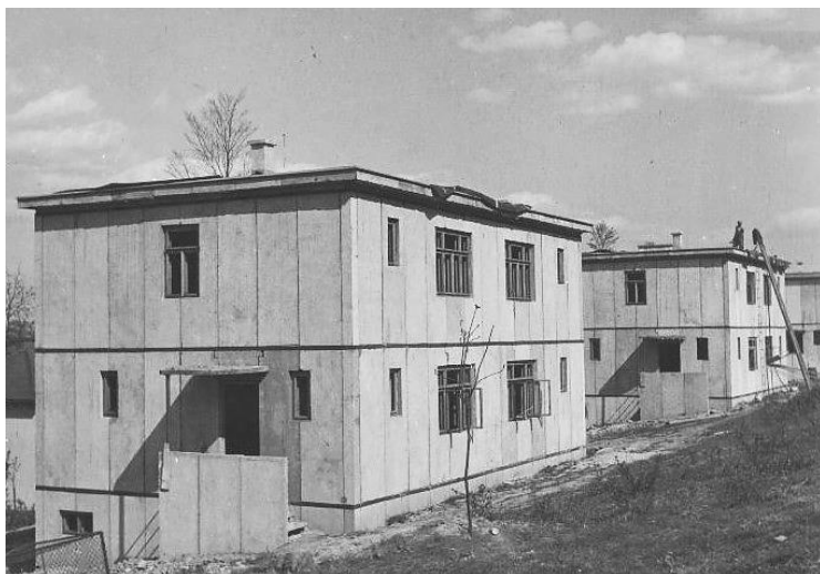
Obr. 66. Zlín. Stavba montovaných dvojdomků, dobový snímek. 241
