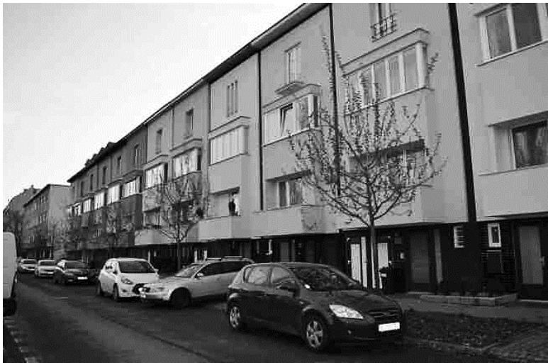
Obr. 15. Alois a Vilém Kubovi. Brno, ulice Střední. Hlavní průčelí řadových rodinných domů, 2017. 74
