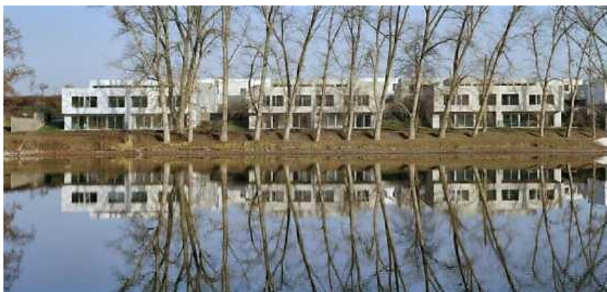
Obr. 247. Terasy Unhošť, pohled na řadové domy z jihu. 649
