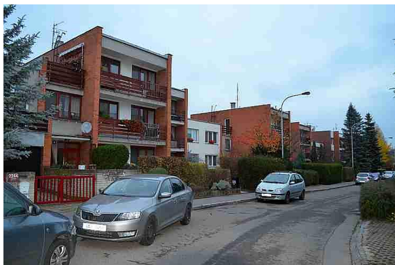
Obr. 150. Obytný soubor na Babě II Západ. Současný stav skupiny č. 201 na ulici Krohova. 469
