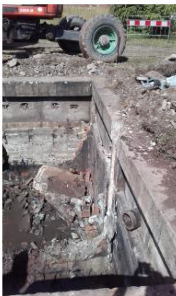
Obrázek č. 10 – Konstrukce septiku při zahájení přestavby na ČOV (Foto: VODAKVA 08/2018).
