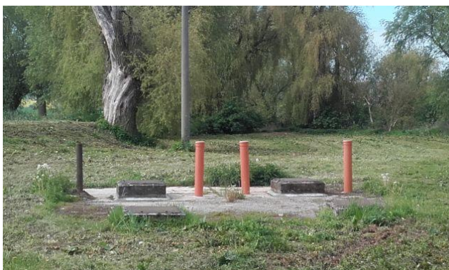
Obrázek č. 9 – Pohled na septik před výstavbou nové ČOV (Foto: VODAKVA 05/2017).
