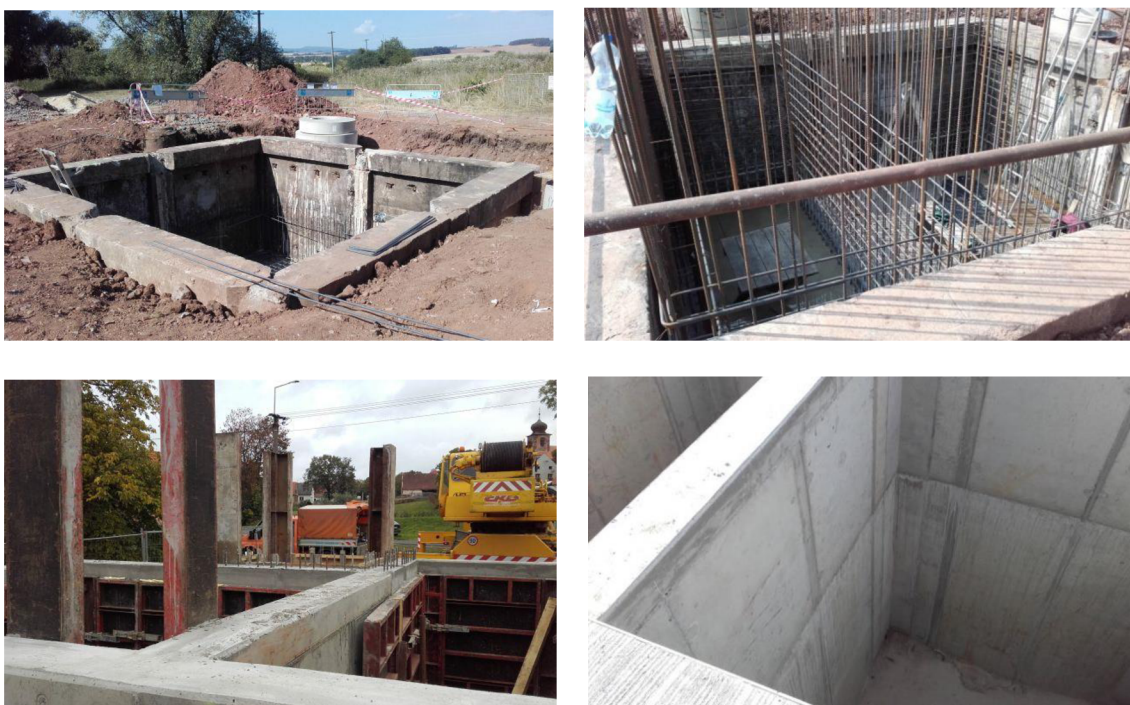
Obrázek č. 11, č. 12, č. 13, č. 14 – Výstavba ČOV Močidlec (Foto: VODAKVA 08 - 10/2018).
