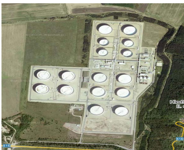
Obrázek 7: Letecký pohled na Centrální tankoviště ropy Nelahozeves
