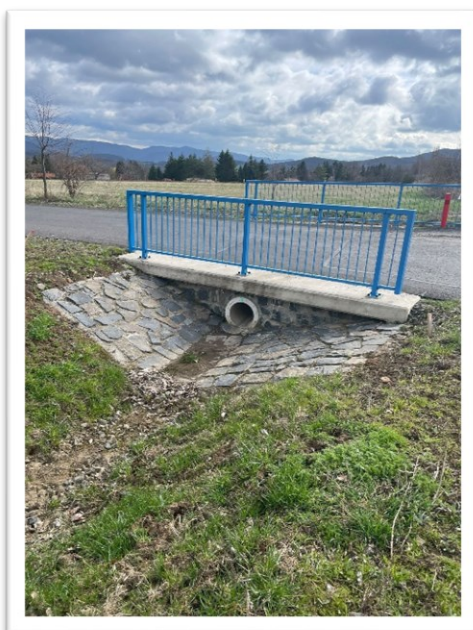
Obrázek č. 45: odvodňovací příkop, zdroj: autorka
