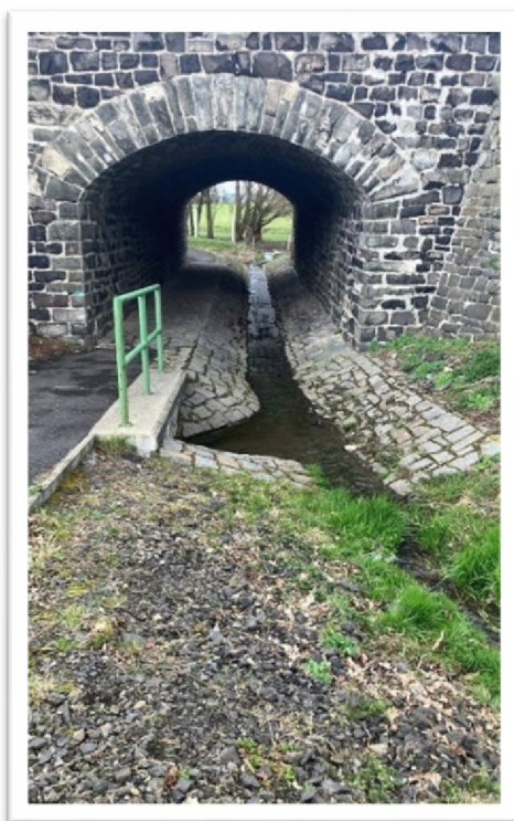
Obrázek č. 44: Žimský potok – viadukt, zdroj: autorka
