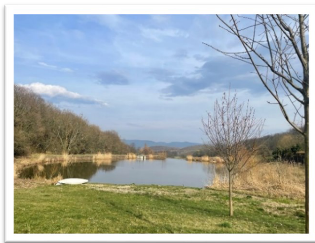
Obrázek č. 42: pohled na vodohospodářské opatření Žim – Záhoří, zdroj: autorka
