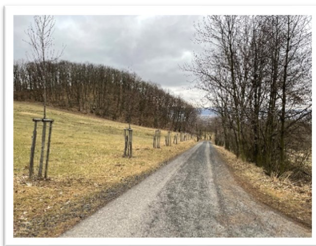
Obrázek č. 15: cesta C23, včetně doprovodné výsadby, zdroj: autorka
