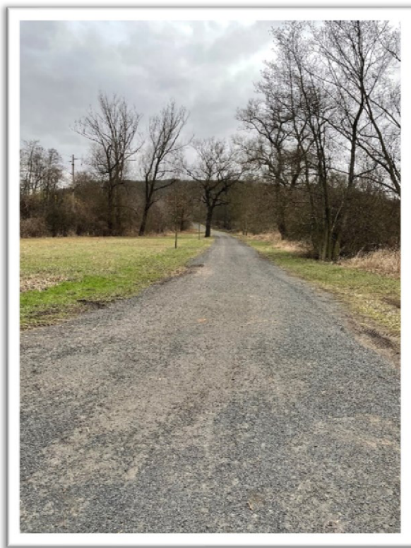
Obrázek č. 18: cesta VPC8, včetně doprovodné výsadby, zdroj: autorka
