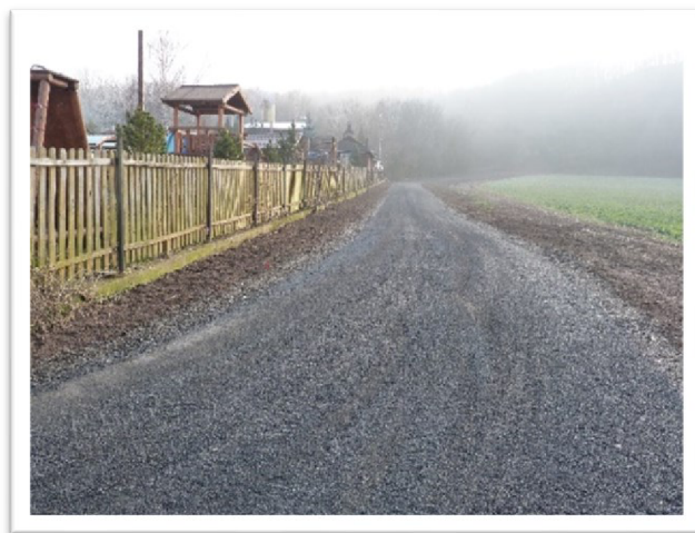
Obrázek č. 28: cesta HPC9, pohled od obce Lelov, zdroj: Státní pozemkový úřad
