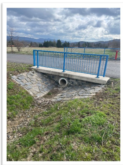
Obrázek č. 45: odvodňovací příkop, zdroj: autorka
