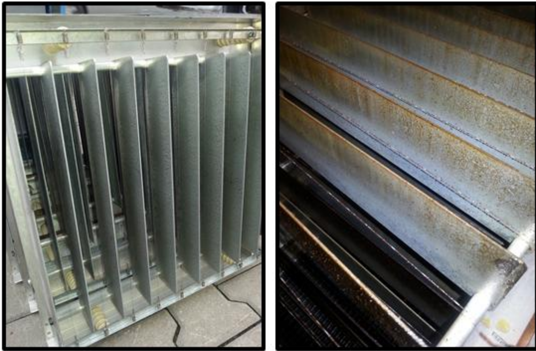
Obr. 23: Vyčištěné filtry (vlevo) a znečištěné filtry po půlročním provozu (vpravo) Zdroj: vlastní
