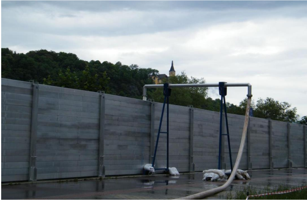
Obrázek 3 Protipovodňová stěna (Zdroj: IROZHLAS.CZ, 2013)
