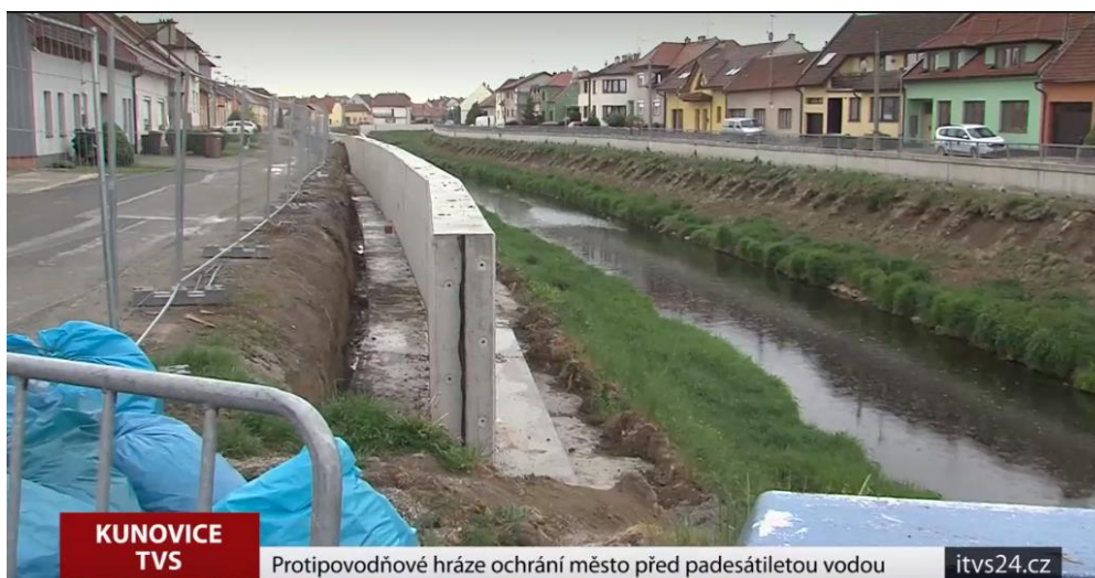
Obrázek 2 Protipovodňová hráz (ITVS, 2020)
