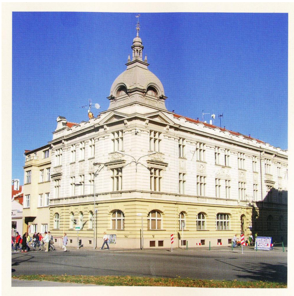
Příloha č. 1: fotografie budovy Základní umělecké školy Vl. Ambrose v Prostějově
