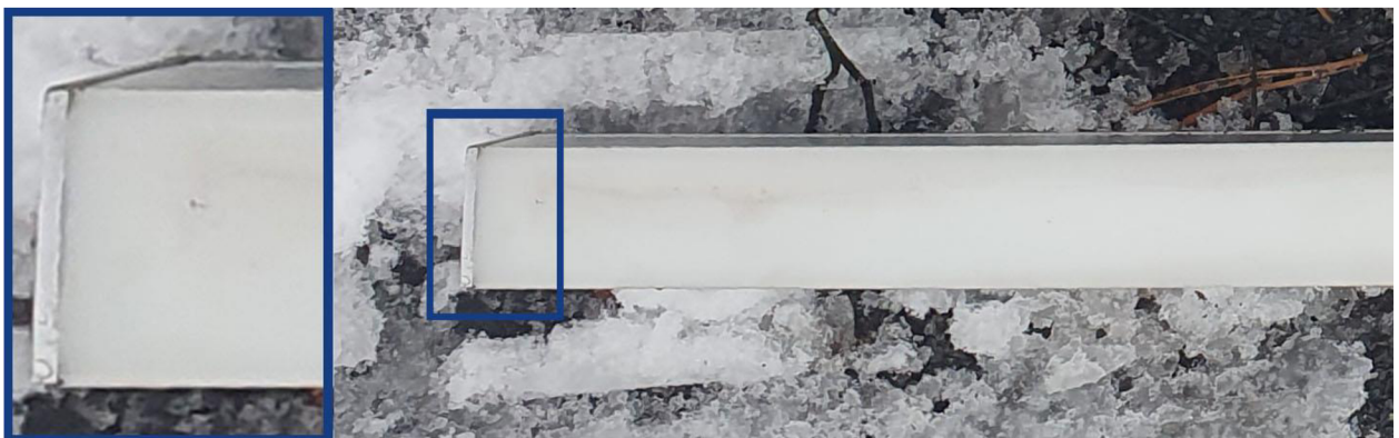
Obr. 6.8 Detail boční strany svítidla (nedošlo ke smrštění a odtržení hmoty od profilu).
