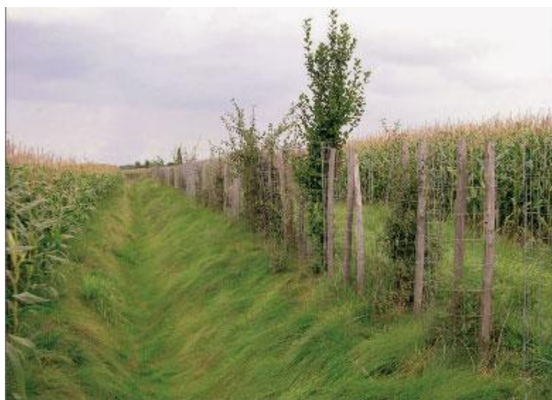
Obr. 5: Protierozní příkop (URL 4)
