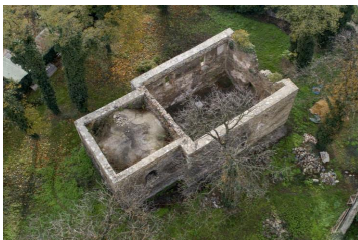
Obrázek č. 3 / celkový pohled na kostel Všetech svatých
