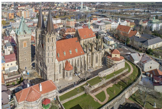
Obrázek č. 60 / Chrám sv. Bartoloměje- pohled od jihozápadu
