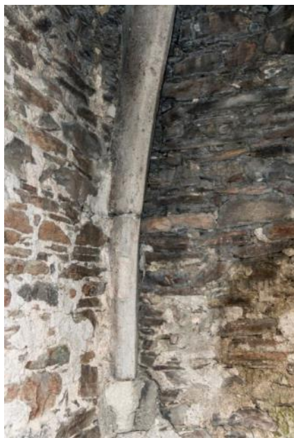
Obrázek č. 2 / klenební žebro a konzola v severovýchodním koutu presbytáře
