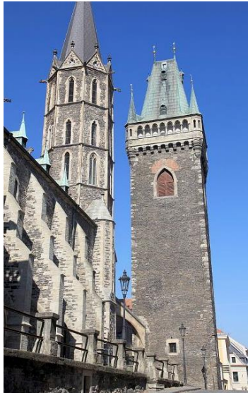
Obrázek č. 56 / exteriér zvonice
