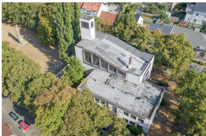
Obrázek č. 20 / celkový pohled kostel
