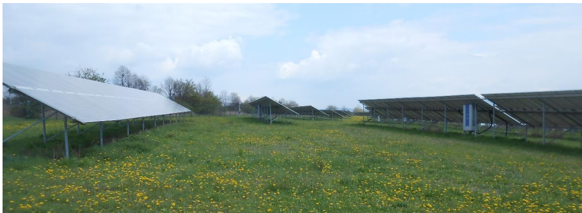
Obrázek 29: Detail FVE v obci Polom (špatné umístění)
