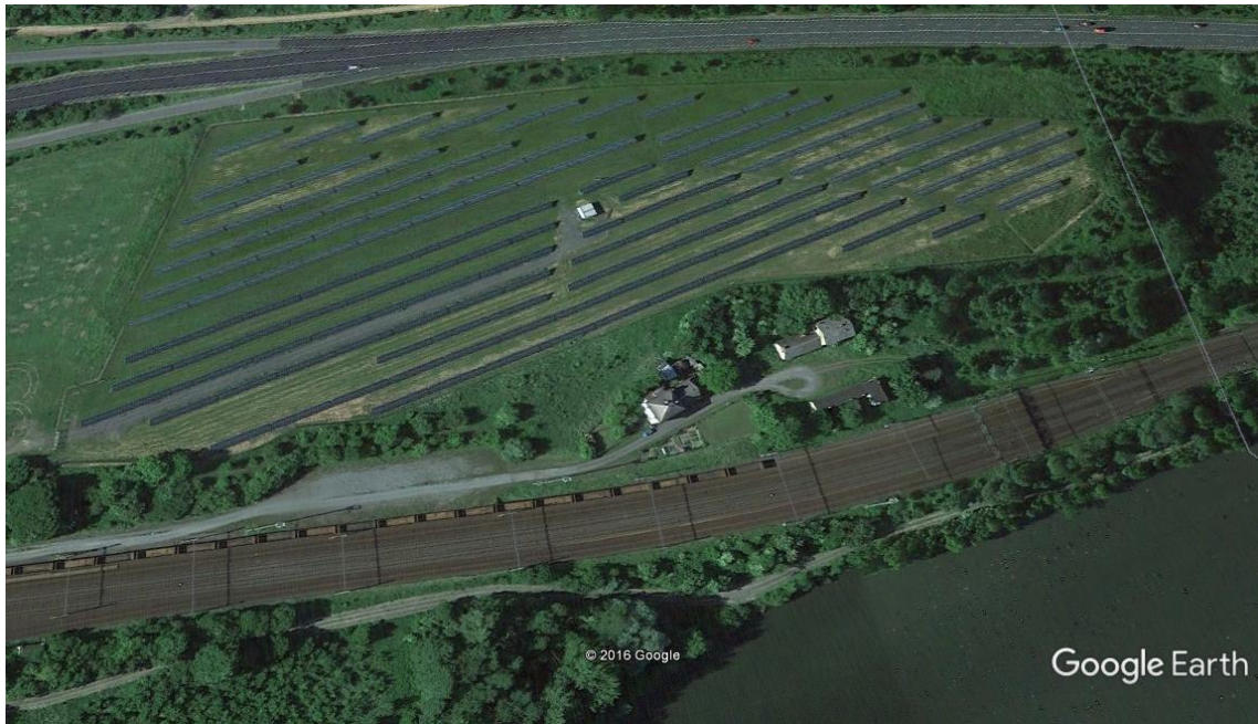
Obrázek 28: Letecký snímek FVE v obci Polom (špatné umístění)
