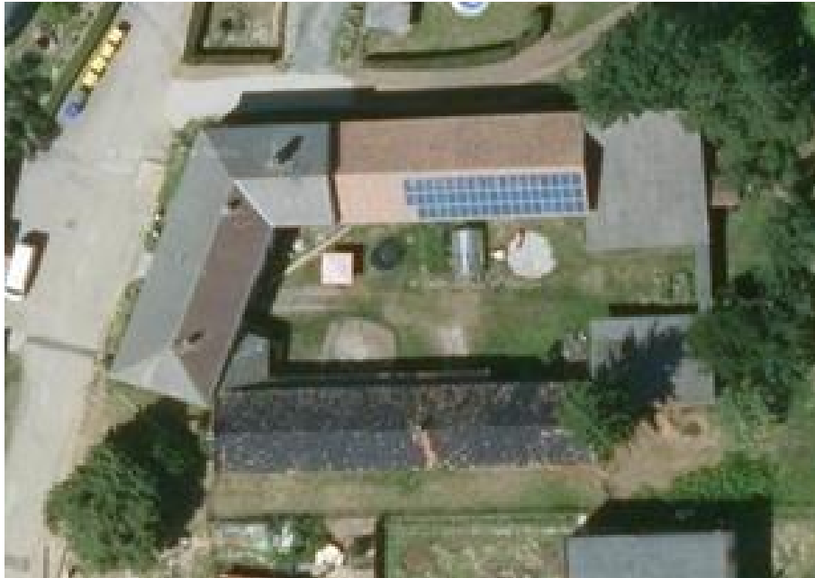
Obrázek 6-1 Pohled na fotovoltaickou elektrárnu
