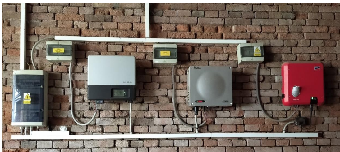
Obrázek 6-3 Pohled na střídače
