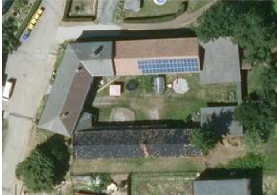
Obrázek 6-1 Pohled na fotovoltaickou elektrárnu
