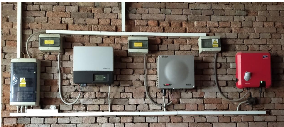
Obrázek 6-3 Pohled na střídače
