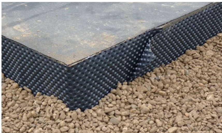
Obrázek 2: Nopová folie při zakládání staveb [6].
