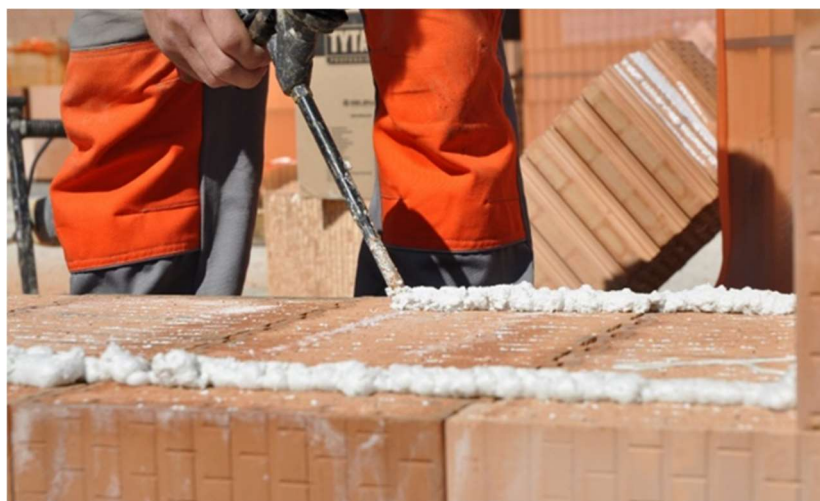
Obrázek 12: Novodobá ukázka spojování cihel pomocí polyuretanové pěny [24].
