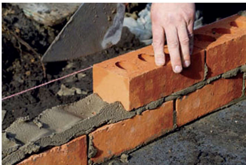
Obrázek 13: Klasické zdění pomocí malty [25].
