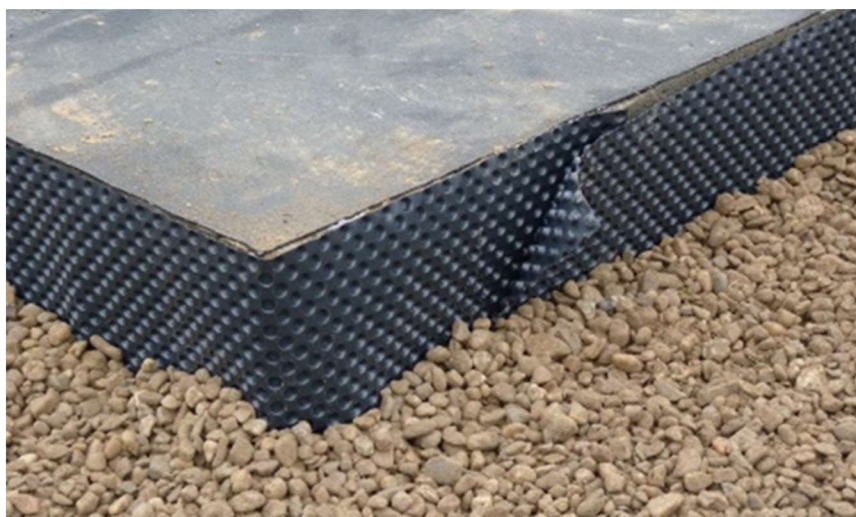
Obrázek 2: Nopová folie při zakládání staveb [6].
