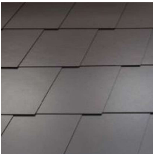
Obrázek 32: Vláknocementové šablony na střešní krytině [70].
