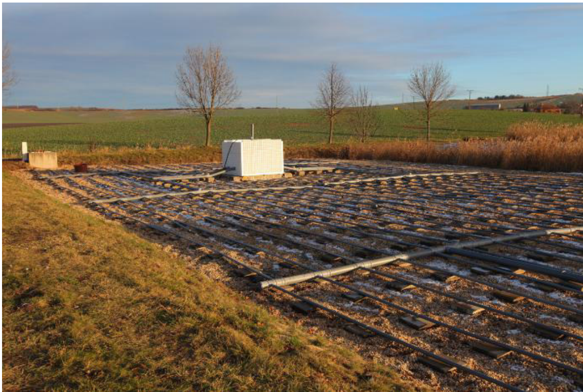
Obr. 33 Ukázka vertikálního filtru zdroj archiv ÚVHK
