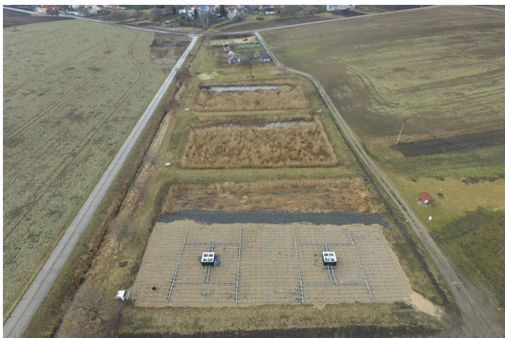
Obr. 7 Ukázka vertikálních (vepředu) a horizontálních (vzadu) filtrů (zdroj archiv ÚVHK)
