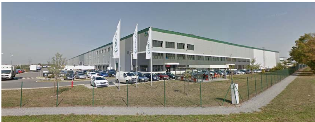
Obrázek 28 - Logistické centrum Mall (Zdroj: https://www.google.com/maps )
