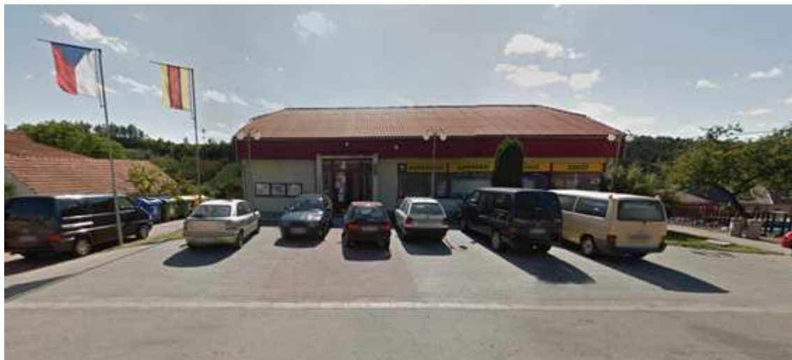
Obr. 12 Exteriér zkoumané maloobchodní prodejny potravin
