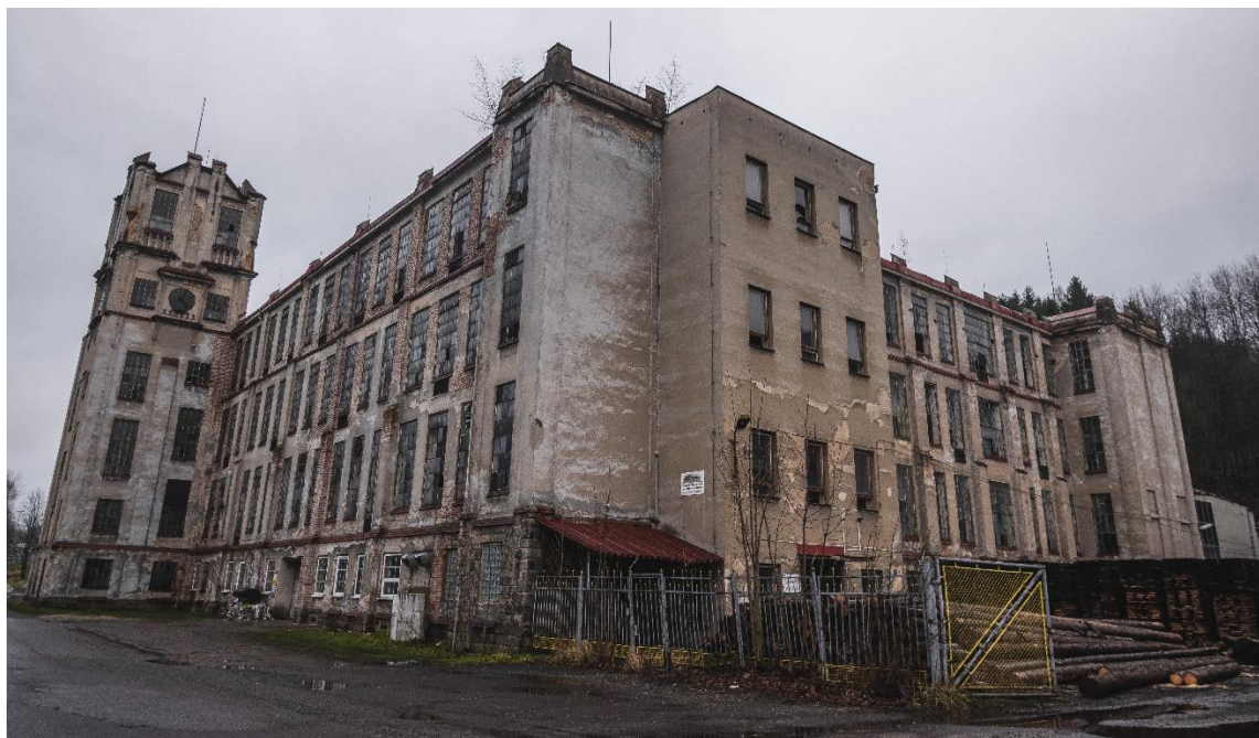
Příloha č. 23 (Johann Liebieg a spol., přádelna, Velké Hamry - Bohdalovice, Mezivodí – současný stav) 139
