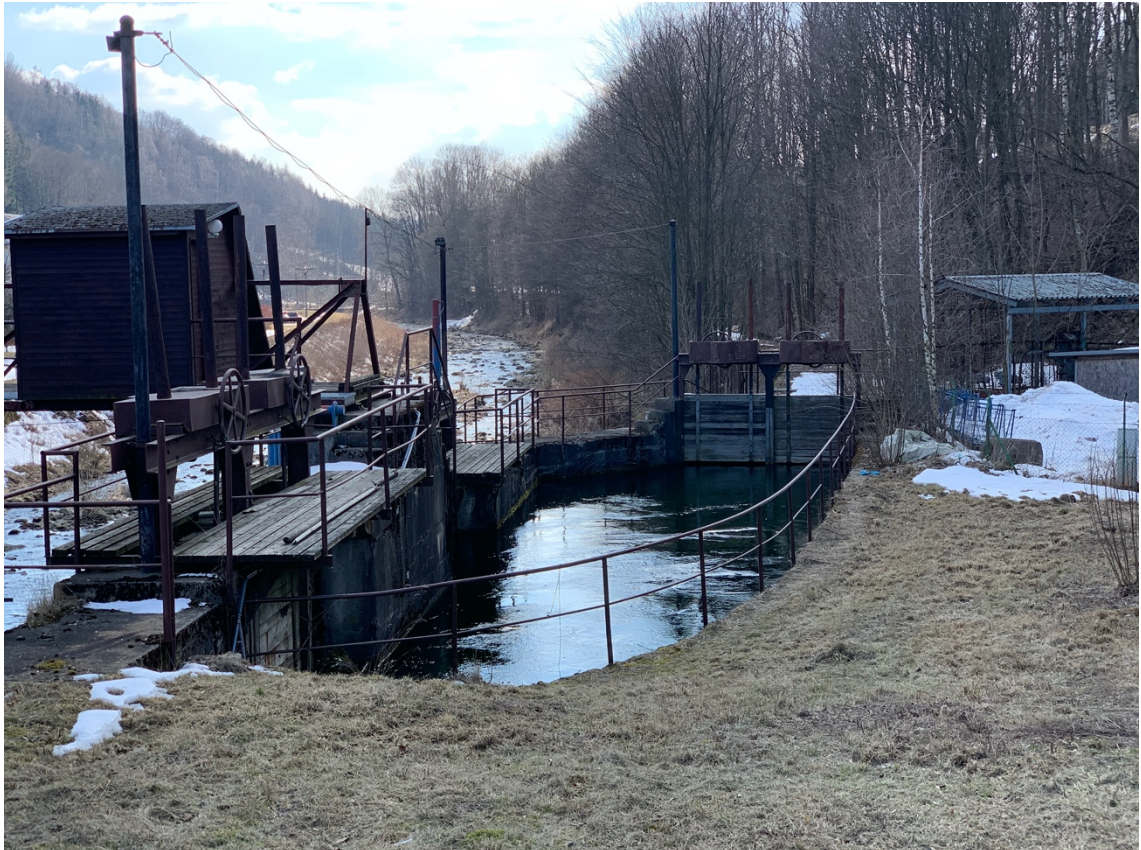
Příloha 9 Počátek náhonu pro Hydroelektrárnu Piette čp. 33 (Wagner, 2021)
