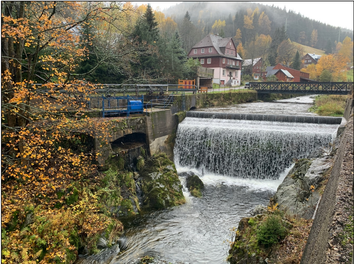
Obr. 7 Jez a začátek náhonu k MVE Pec pod Sněžkou (Wagner, 2020)
