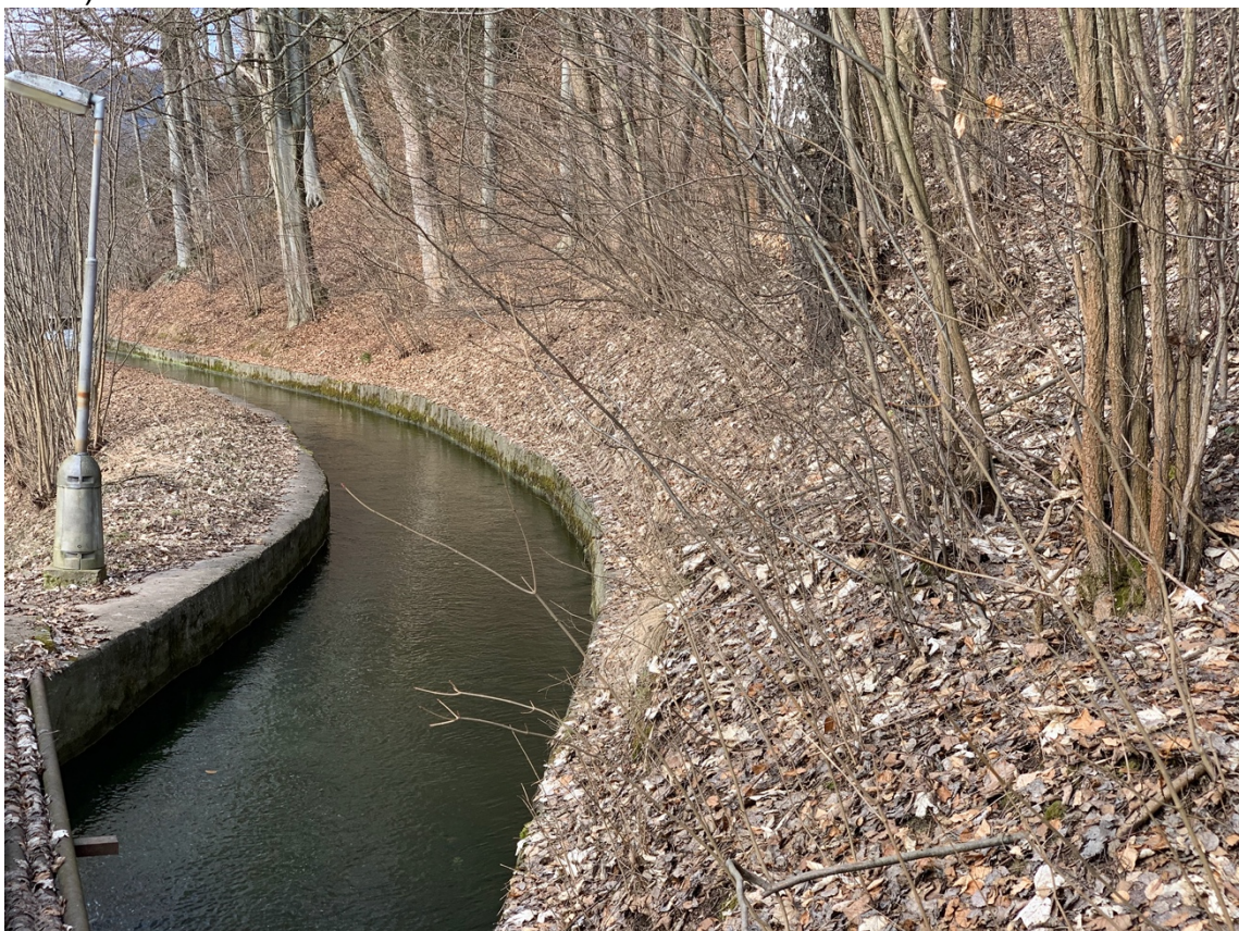
Příloha 14 Ukázka betonového náhonu k papírně Eichmann a Roeder (Wagner, 2021)
