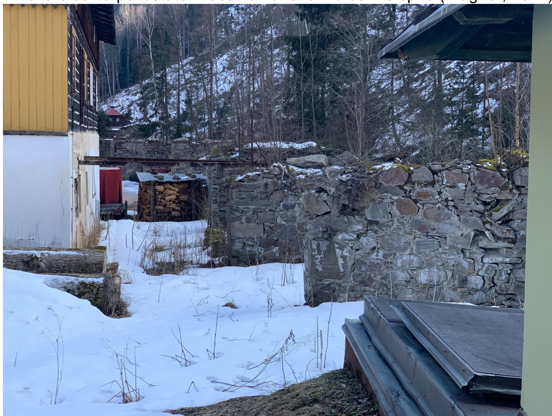
Příloha 6 Kamenné sloupy, na kterých se nacházel dřevěný náhon přivádějící vodu do Dixovy brusírny čp. 71 (Wagner, 2021)
