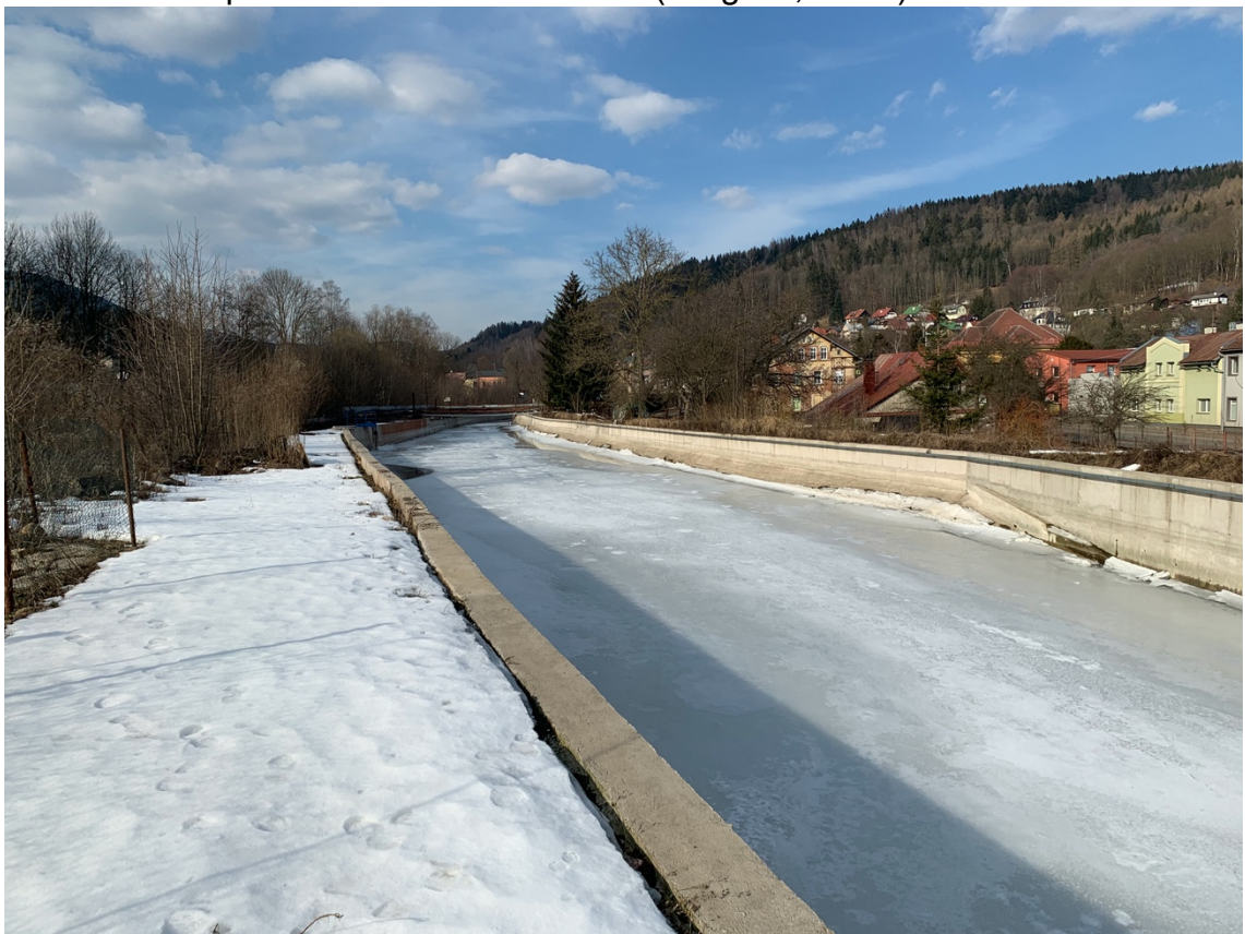
Příloha 16 Nově vybetonovaný náhon k papírně - MVE Svoboda nad Úpou (Wagner, 2021)
