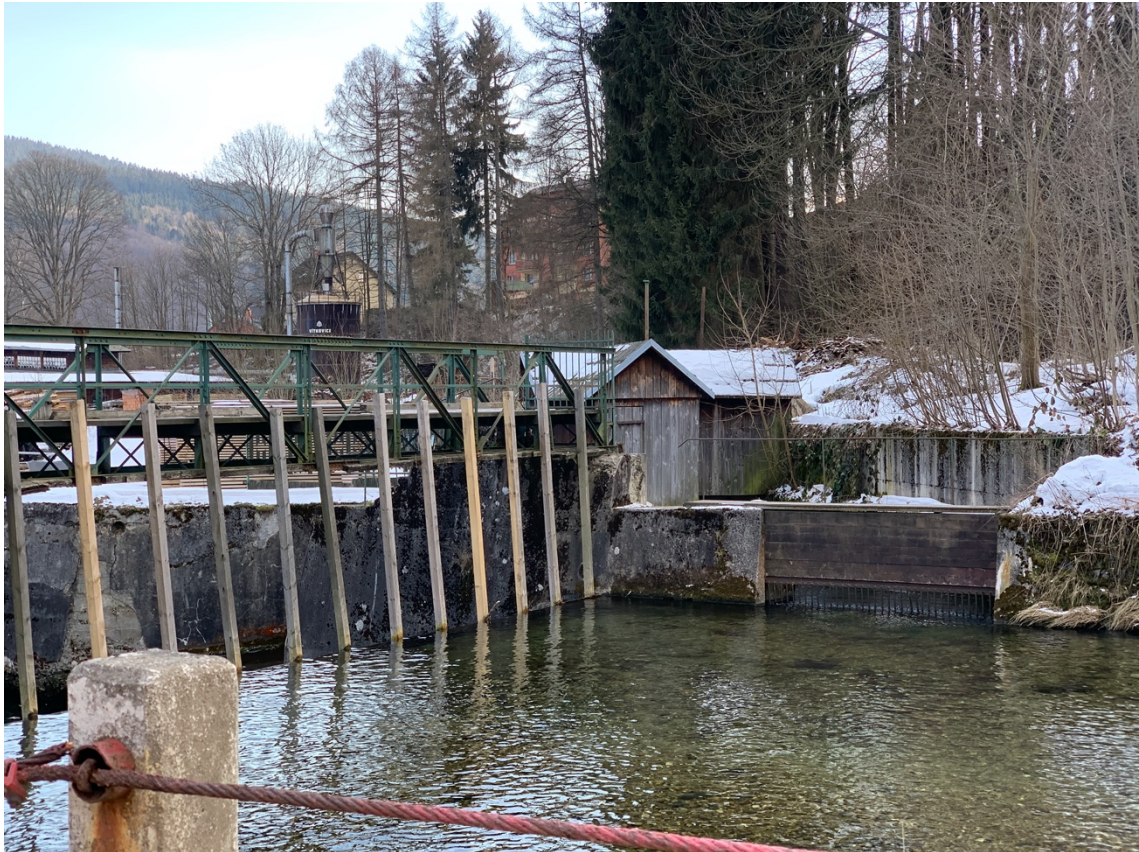
Obr. 28 Jez k vodnímu dílu MVE Horní Maršov I (Wagner, 2021)
