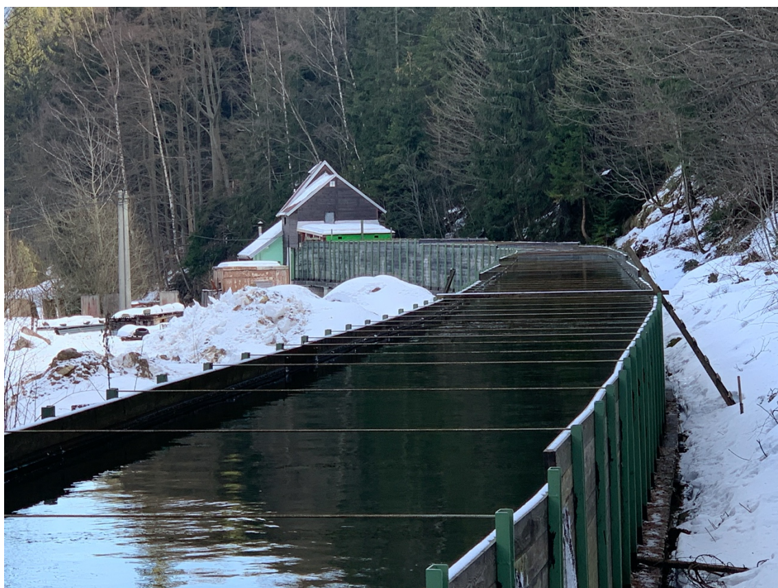
Obr. 23 MVE Temný důl II včetně vodního náhonu (Wagner, 2021)
