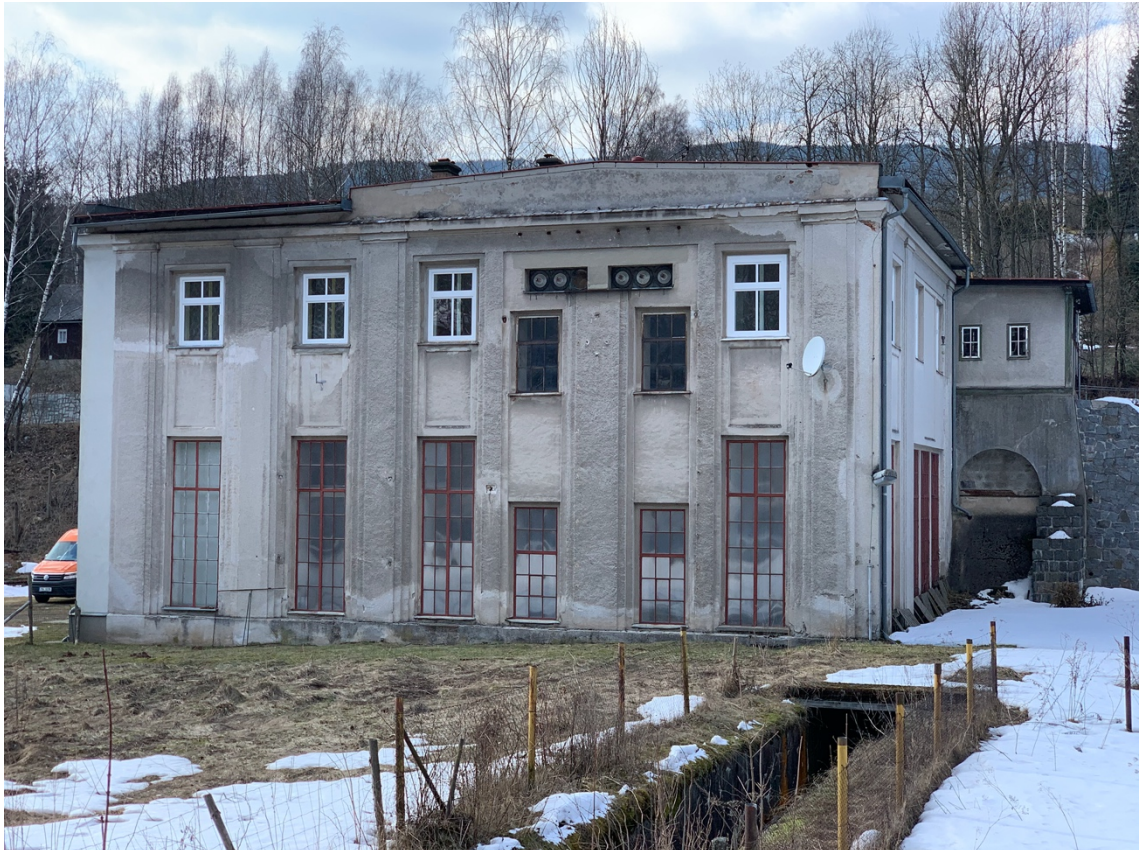
Obr. 33 Hydroelektrárna Piette čp. 33 (Wagner, 2021)
