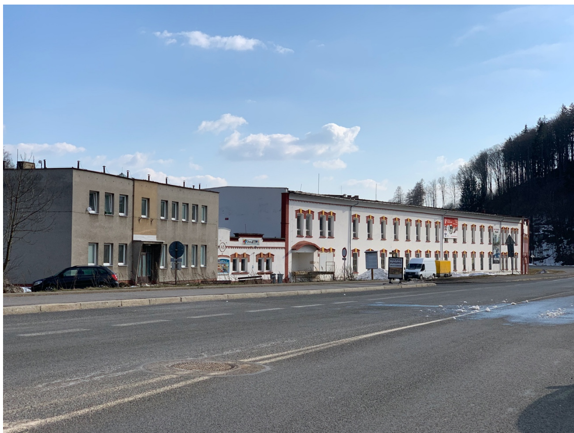
Obr. 37 Budova bývalé Piettovy papírny čp. 13/14 (Wagner, 2021)
