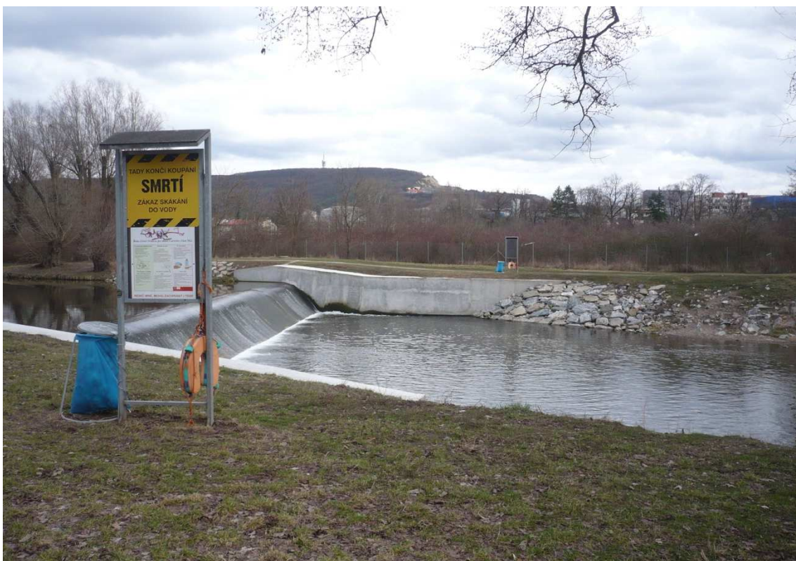
Obr. 5: Bezpečnostní tabule u jezu v prvním hodnoceném úseku. Zdroj: Frantová, 2017
