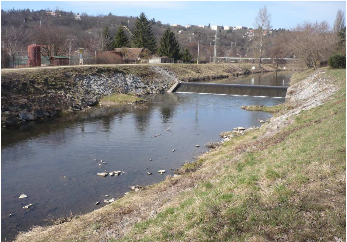
Obr. 6: Biotechnické zpevnění břehu u jezu v hodnoceném prvním úseku. Zdroj: Frantová, 2017
