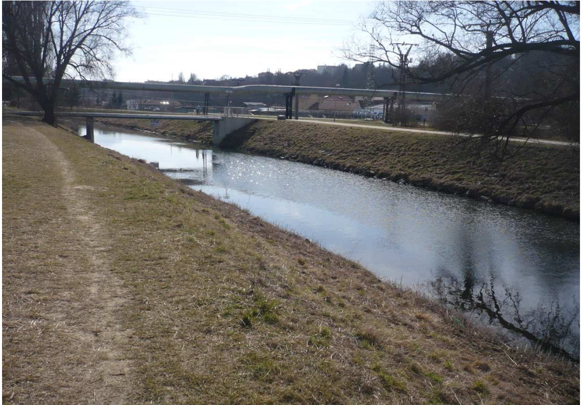
Obr. 8: Pohled na teplovod vedoucí nad nově opravenou lávkou přes řeku Svitavu. Zdroj: Frantová, 2017
