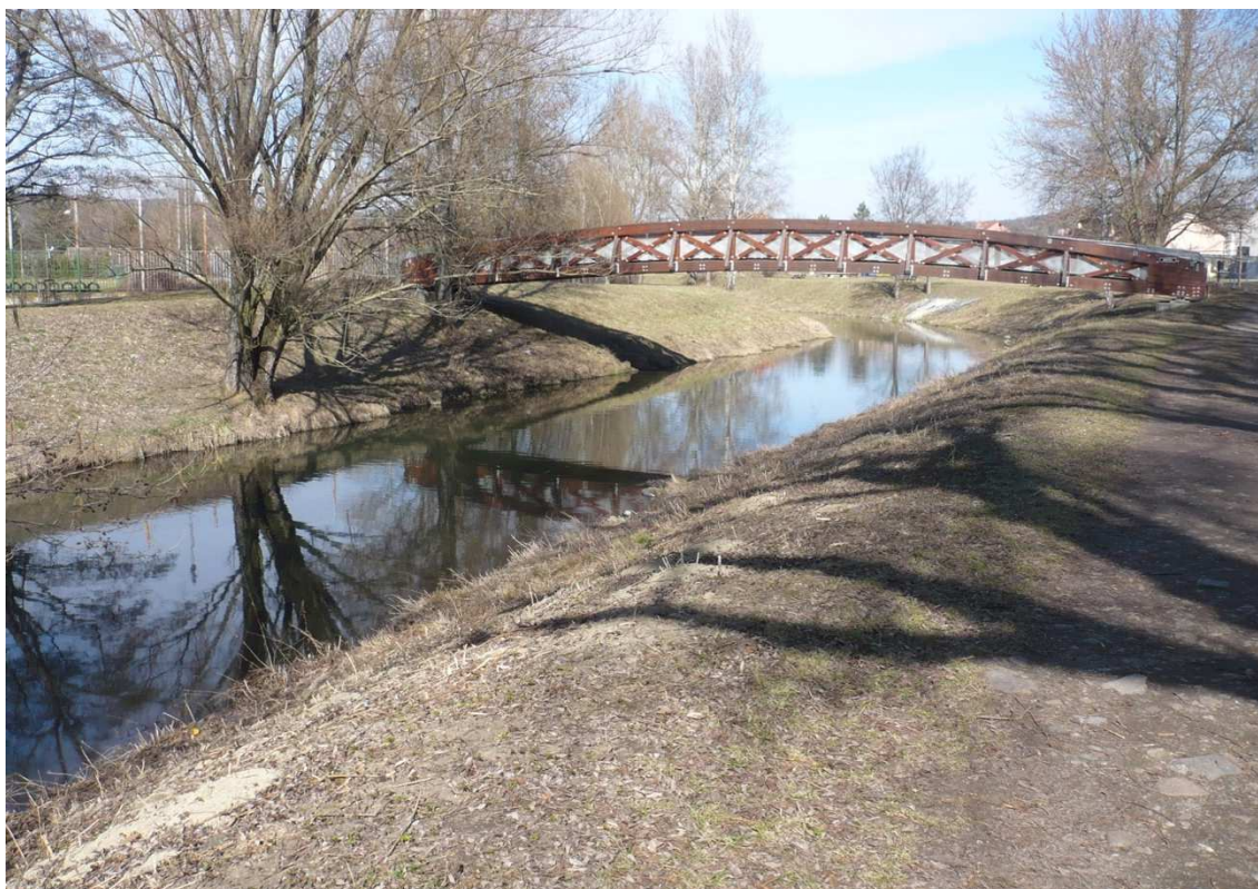
Obrázek 5: Nově vybudovaná lávka přes řeku Svitavu před ragbyovým hřištěm. Zdroj: Frantová, 2017
