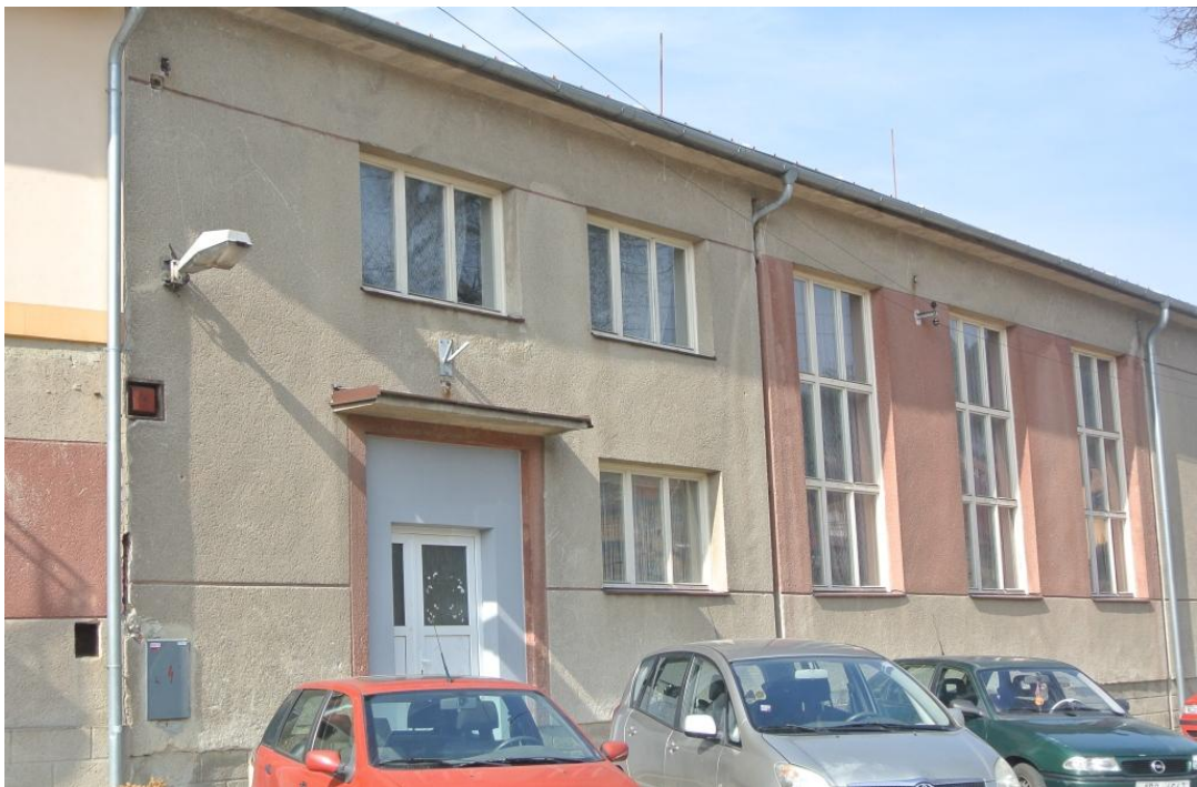
Příloha č. 6 Budova Kulturního domu
