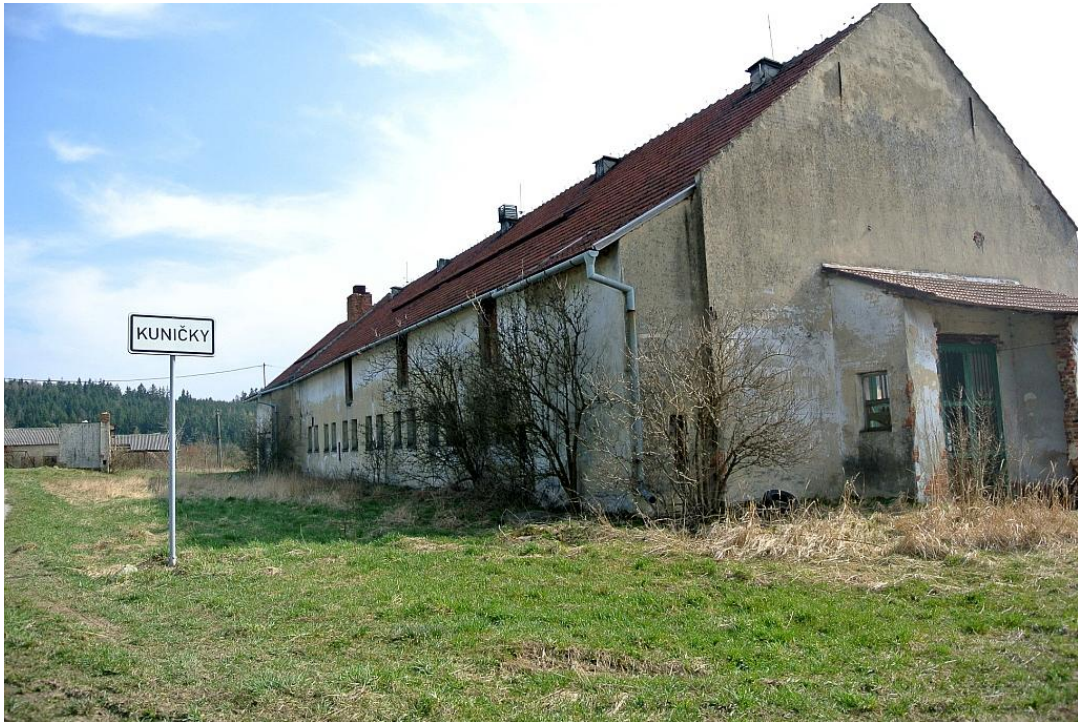
Příloha č. 9 Pohled na bývalý kravín
