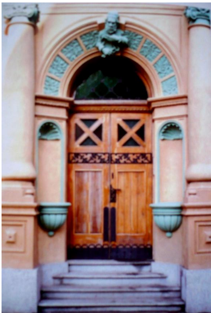
Vstupní portál, foto archiv autorky práce
