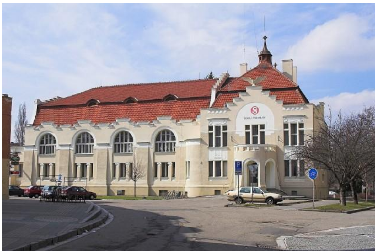
Sokolovna v Prostějově – celkový pohled směrem od zámku, foto archiv autorky práce
