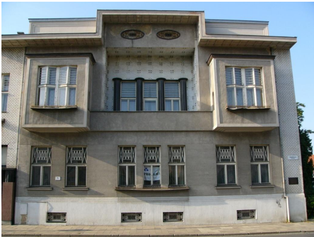
Vila Josefa Kovaříka – pohled na hlavní vchod, foto archiv autorky práce
