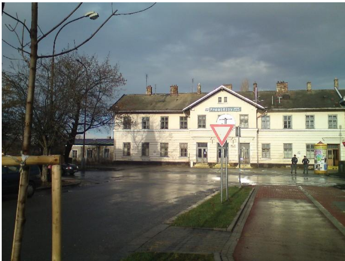
Místní vlakové nádraží Prostějov – pohled na levou část objektu směrem od náměstí T. G. Masaryka, foto archiv autorky práce
