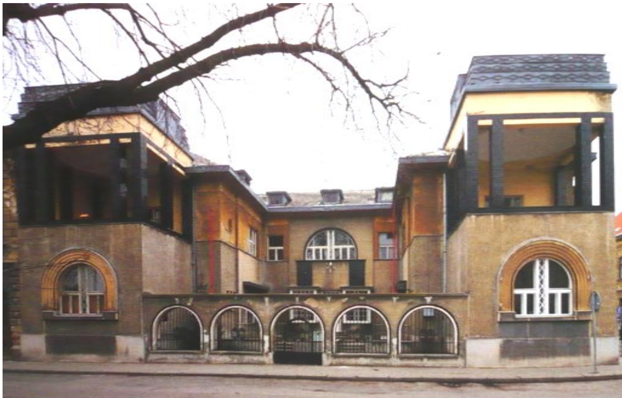
Vila Josefa Kovaříka – pohled na hlavní vchod, foto archiv autorky práce
