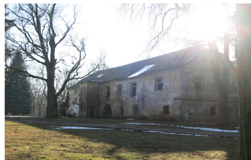
Obr. č. 13/ Ručně malovaný obraz zámečku z roku 1865 ve srovnání se současným stavem
