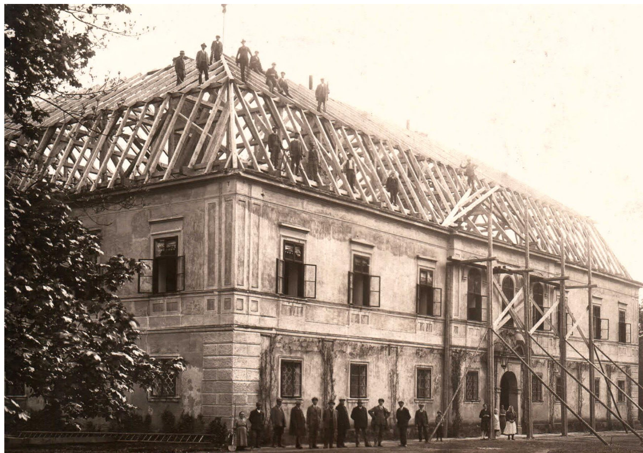
Obr. č. 3/ Rekonstrukce střechy zámku po požáru 1927
