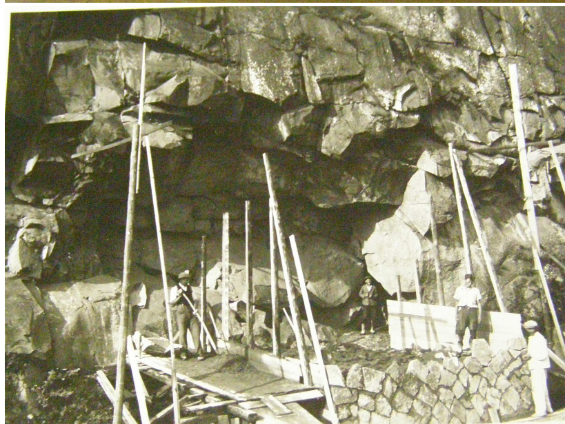
24. Kunětická hora, zpevnování rozpadajících se skály, rok. 1941
