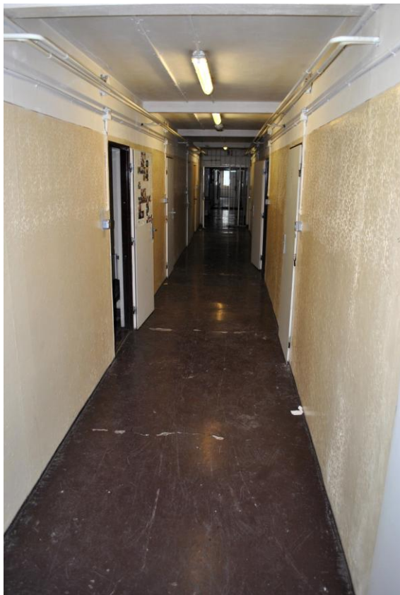
Obr. 43 Prostory prvního cvičení
