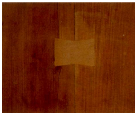
Obr. 20: Motýlový spoj (Losos, 2013)
