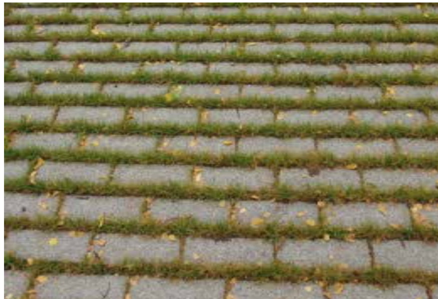
obr. 8 - zatravněná betonová dlažba, Riemer Park, Mnichov, Voda ve městě (2021)
