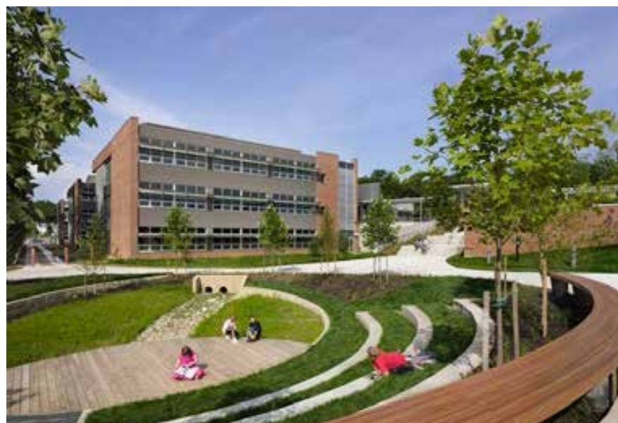
obr. 27 - suchá retenční nádrž ve veřejném prostoru před základní školou, Virginia, USA, Prakash Patel, Voda ve městě (2021)
