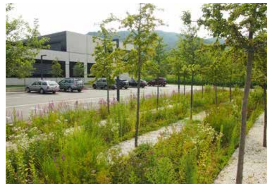
obr. 23 - osázená vsakovací rýha s povrchovým přítokem, FBS Warmbad, Villach, Voda ve městě (2021)
