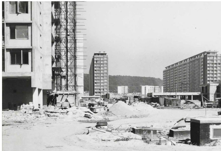
obr. 35 - dokončované sídliště Ďáblice v roce 1975, Archiv hlavního města Prahy, dostupné z: http://katalog.ahmp.cz/pragapublica/permalink?xid=E72EA-086366711E7B9CE406186009F3A&scan=1#scan1
