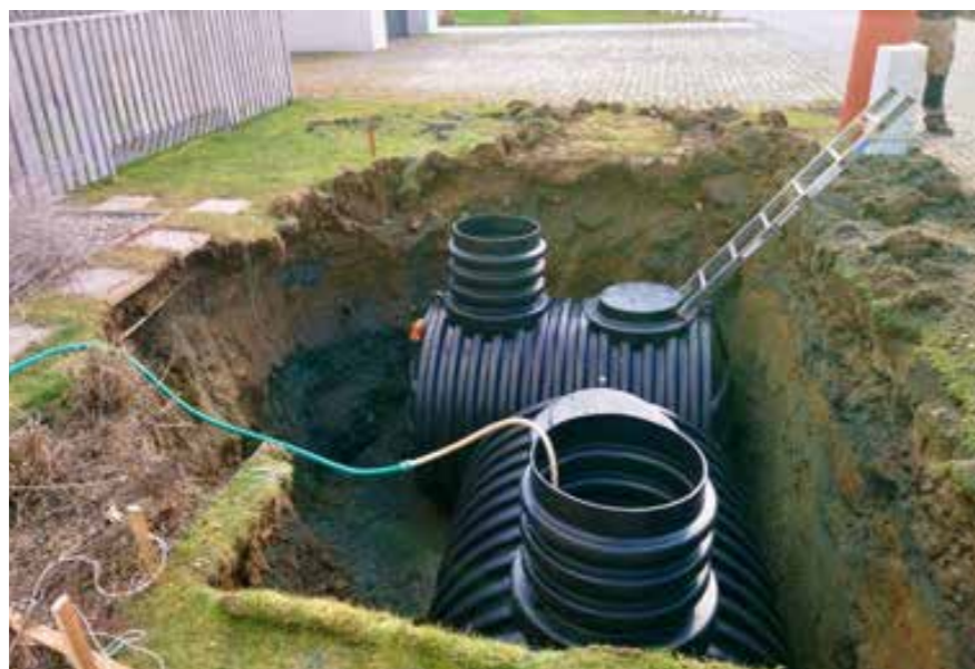
obr. 31 - plastová akumulční nádrž, dostupné z: https://www.robicont.cz
