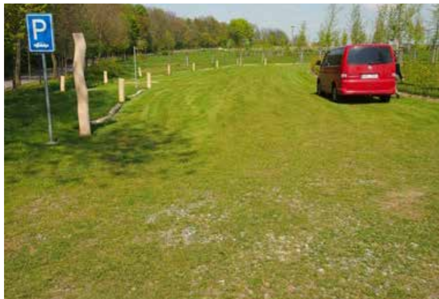
obr. 9 - štěrkový trávník na parkovišti, hřbitov Dolní Břežany, Voda ve městě (2021)
