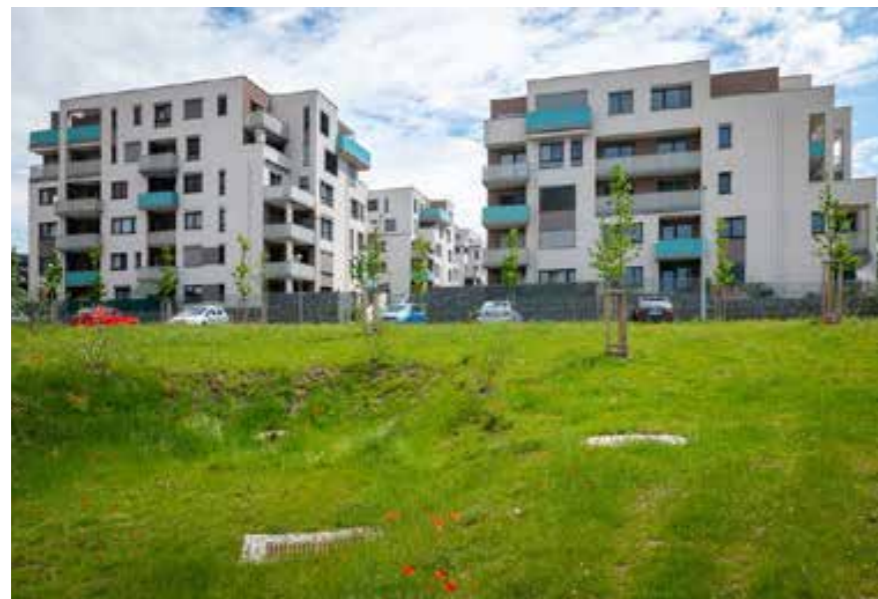
obr. 25 - vsakovací retenční nádrž, SUOMI Hloubětín, Praha, Vojta Herout, dostupné z: https://www.adaptterraawards.cz/Databaze/2020/Hospodareni-s-des-tovkou-SUOMI-Hloubetin
