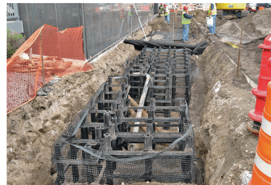
obr. 14 - příklad použití strukturálních buněk, SZKT (2022), dostupné z: https://szkt.cz/clanky-casopisu-zajisteni-prokorenitelneho-prostoru-pro-stromy-v-mest-skych-ulicich-ii
