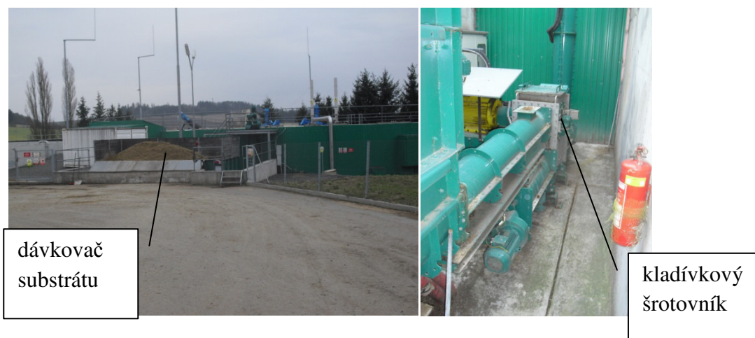
Obrázek č. 5 a 6 – Dávkovač substrátu a kladívkový šrotovník na šnekovém dopravníku (Zdroj: autor)
