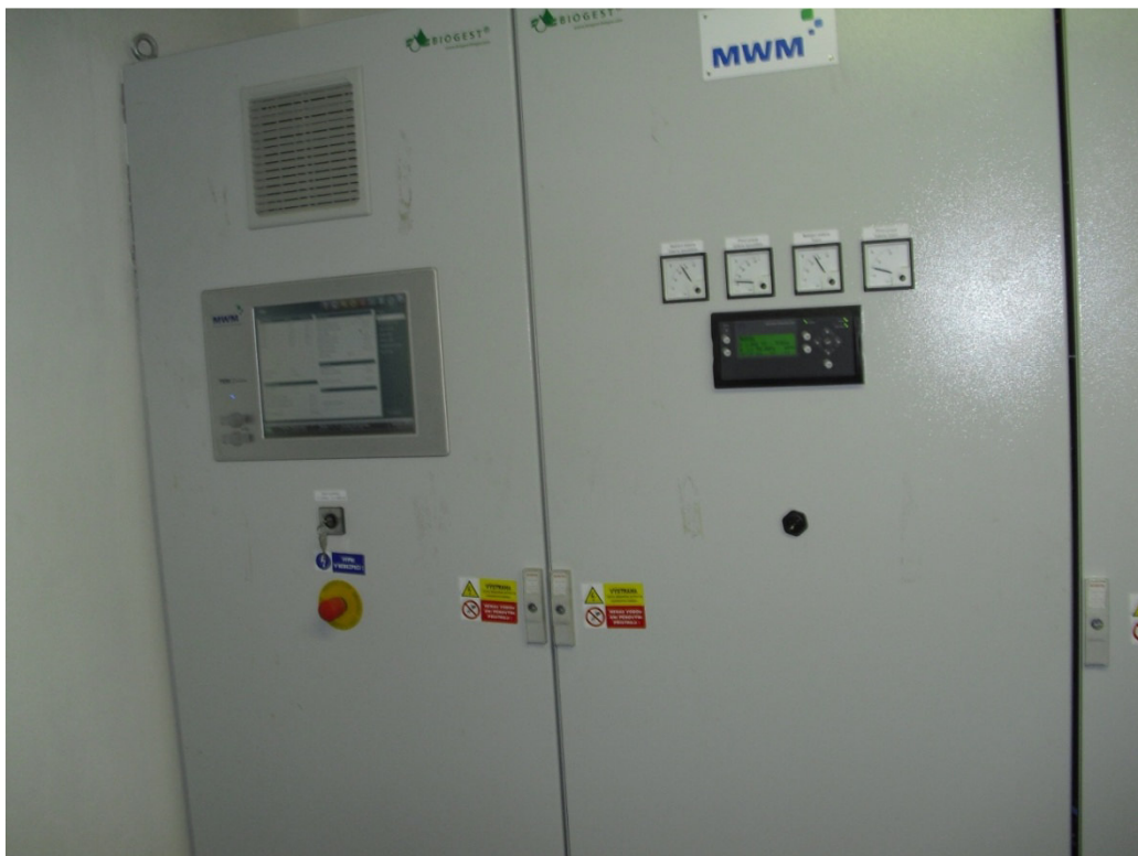
Obrázek č. 10 – Strojovna s počítačem, který ovládá kogenerační jednotku (Zdroj: autor)
