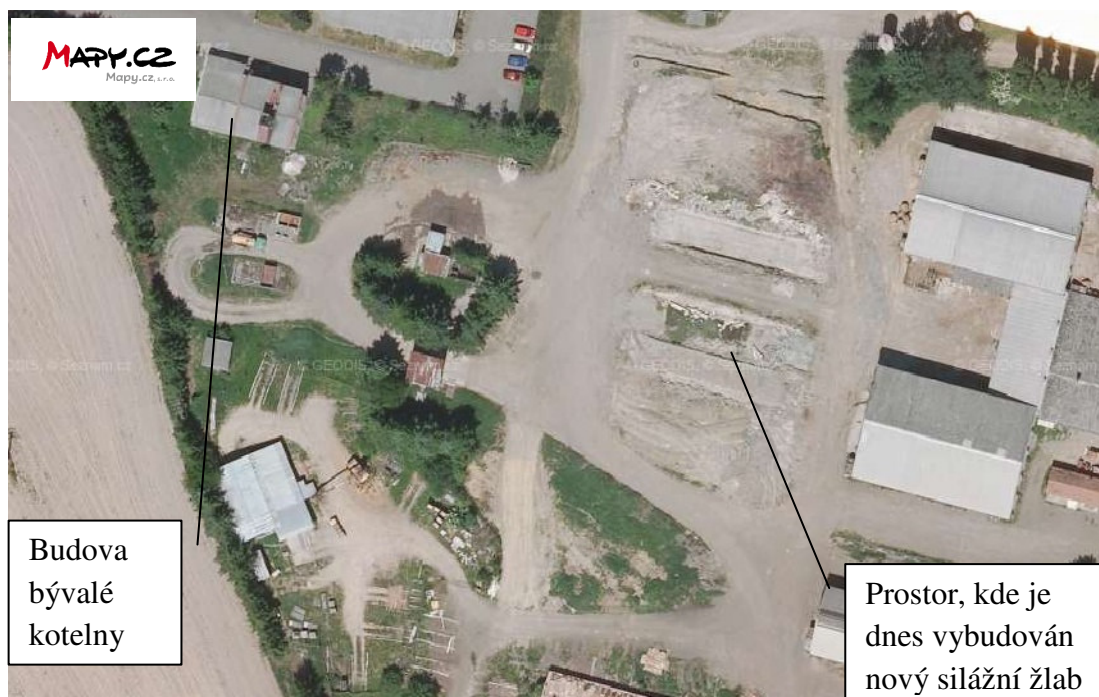
Obrázek č. 12 – Letecký pohled na prostor před vybudováním bioplynové stanice (Anonymus 11)
