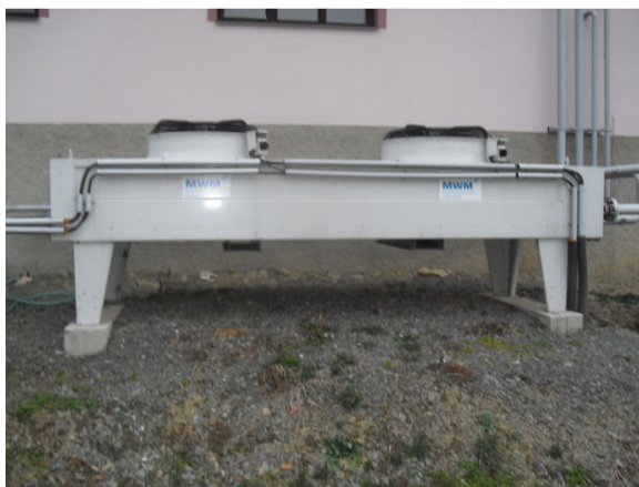
Obrázek č. 14 – Chladič na odpadní teplo (Zdroj: autor)
