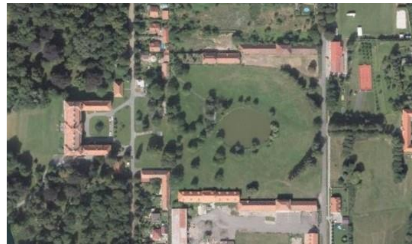
Obrázek 39: Letecký snímek současného stavu areálu s chaoticky rozmístěnými dřevinami bránícími v průhledech a v prostupnosti celého prostoru dvora.
