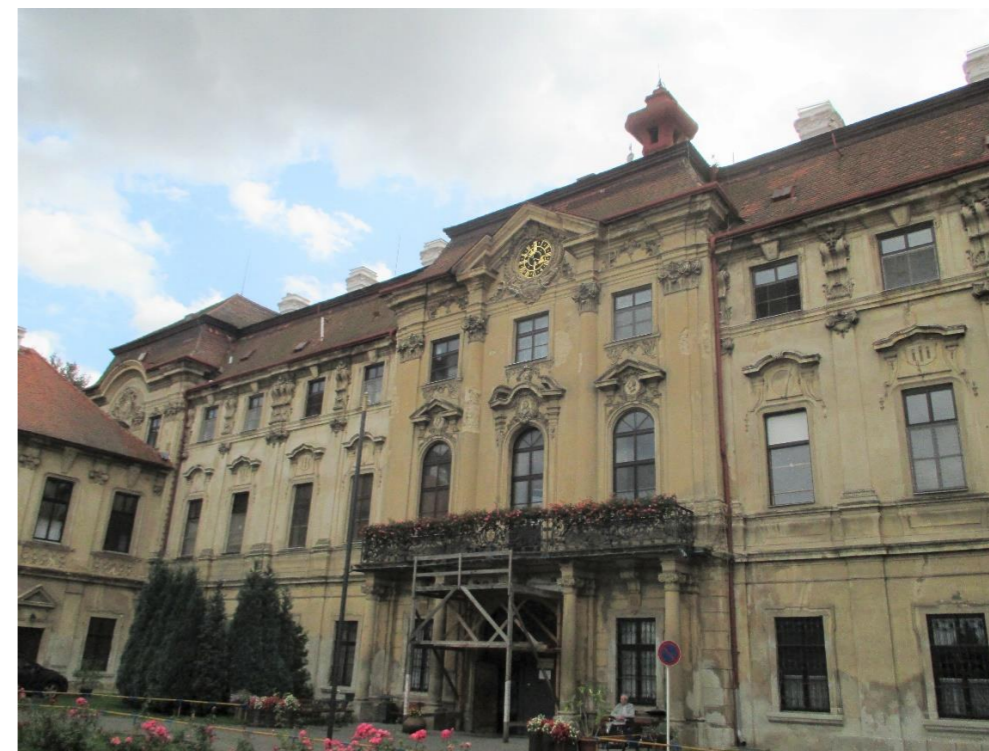
Obrázek 19: Současný stav čelní fasády zámku se vstupem.
