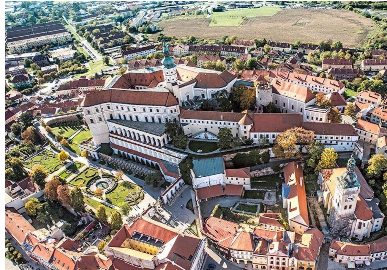
Obrázek 3: Letecký snímek zámku Mikulov. Vlevo zrekonstruované barokní zahradní terasy.
