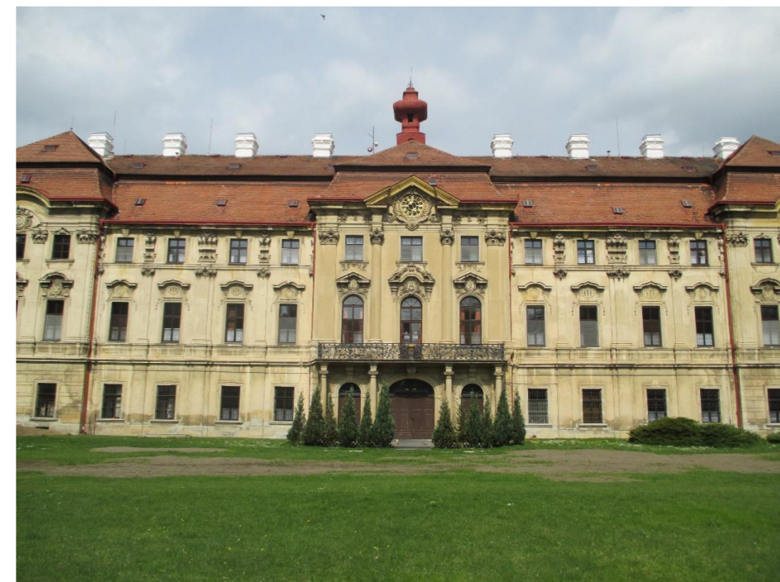
Obrázek 36: Současná podoba zahradního (jižního) průčelí zámku. Foto: Jan Vachuda
