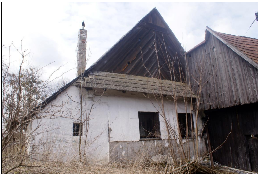
Průčelí usedlosti čp. 22 v Lezníku – stav v roce 2013.
