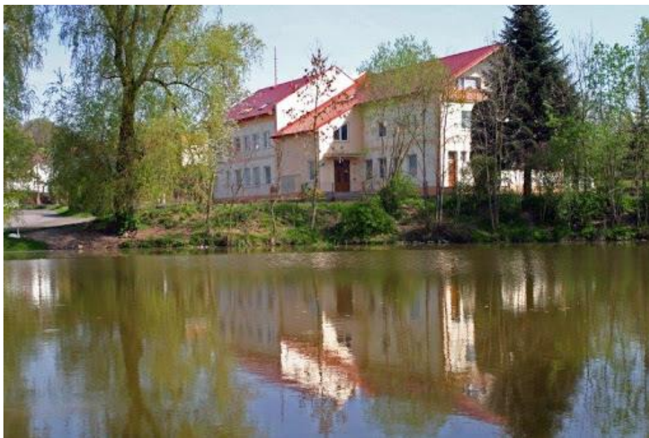
Obrázek 10 Základní a mateřská škola v obci Bolešiny
