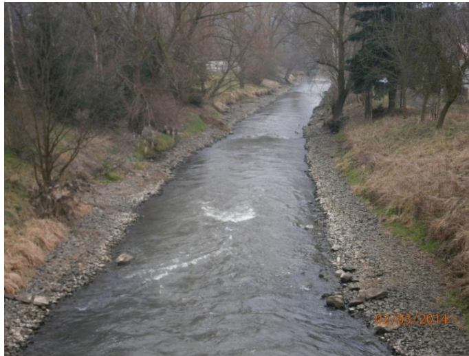
Obr. č. 3 - koryto řeky Bíliny v obci Želenice (Friedrich, 2014)
