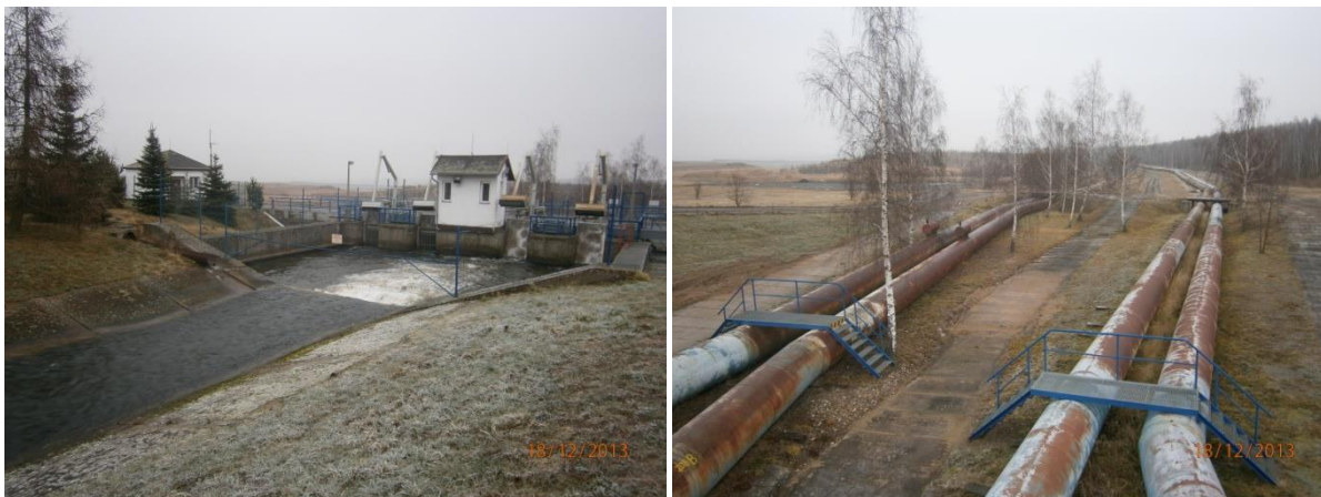
Obr. č. 5 a 6 Ervěnický koridor, řeka Bílina přeložena do potrubí (Friedrich, 2013)
