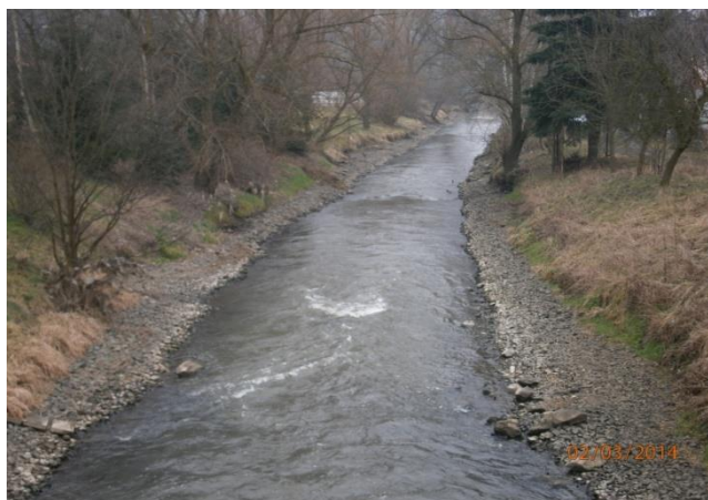
Obr. č. 24 – koryto řeky Bíliny v obci Želenice (Friedrich, 2014)
