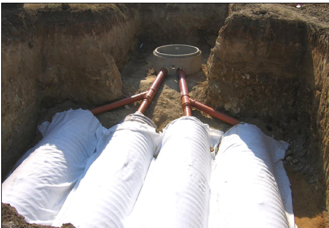
foto č. 7 Systém pro akumulaci a zasakování dešťových vod pomocí tunelového systému
