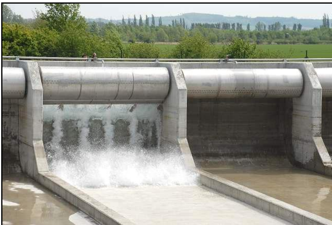
foto č. 13 Dešťová zdrž – vyplachovací klapka Olomouc
