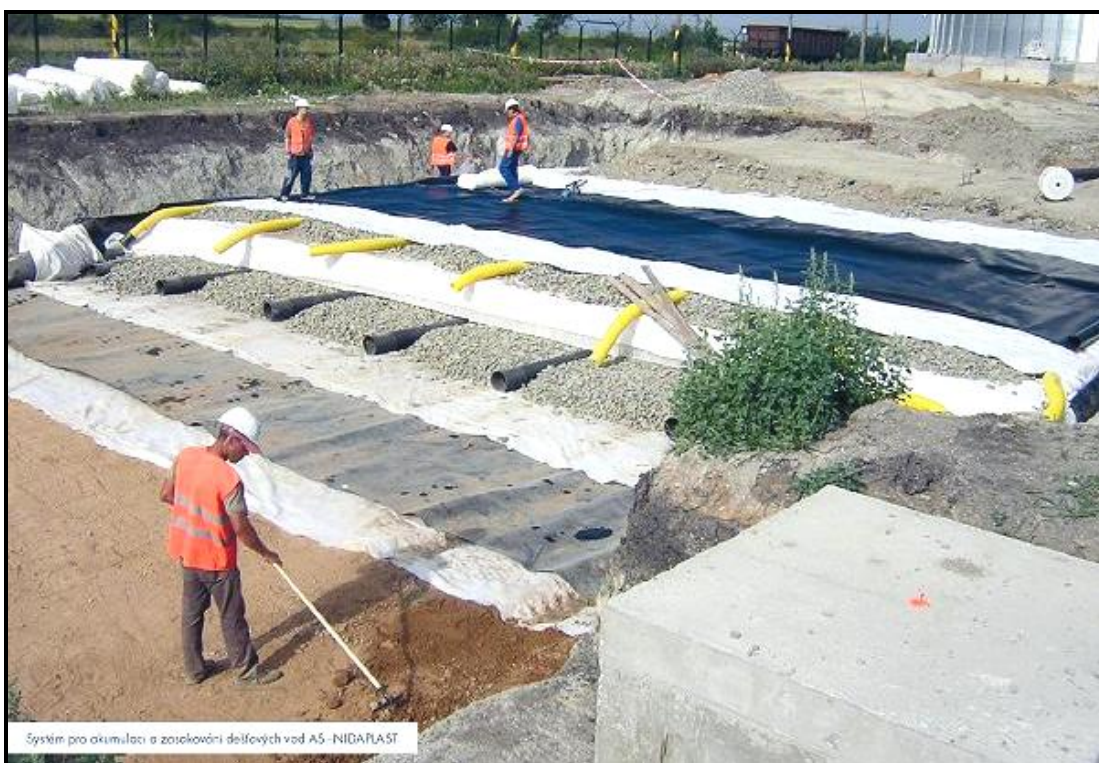
foto č. 4 Systém pro akumulaci a zasakování dešťových vod pomocí plastových bloků
