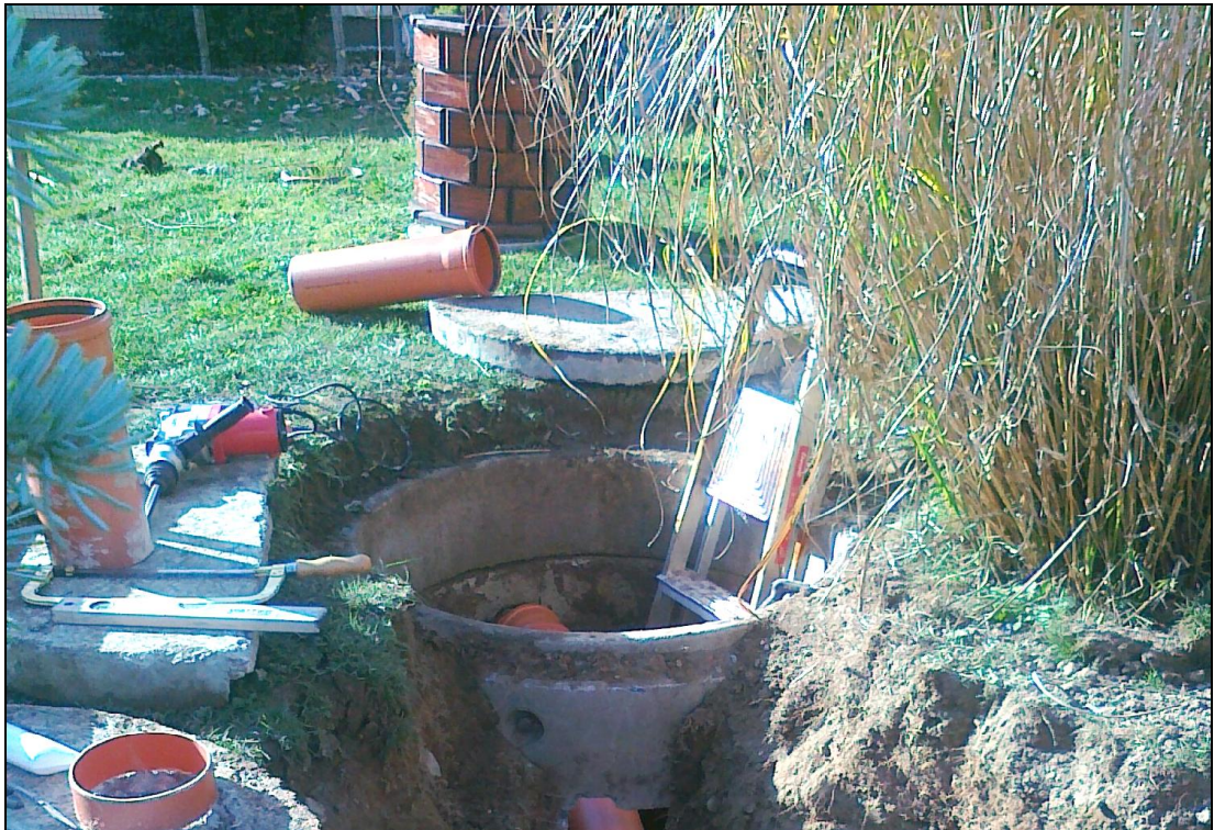
foto č. 1 Stávající jímka rekonstruovaná na dešťovou jímku
