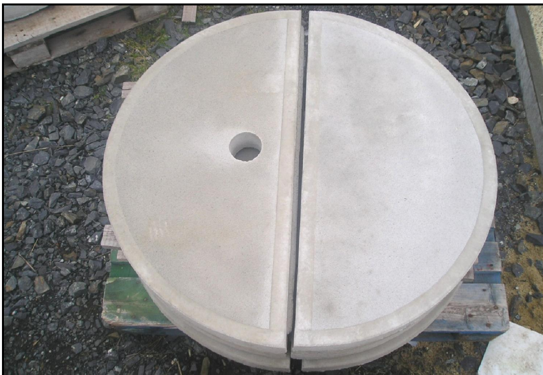
foto č. 3 Betonový poklop DN 1300 – zakrytí nově rekonstruované jímky dešťových vod
