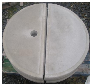
obr. č. 6 - Betonový poklop
