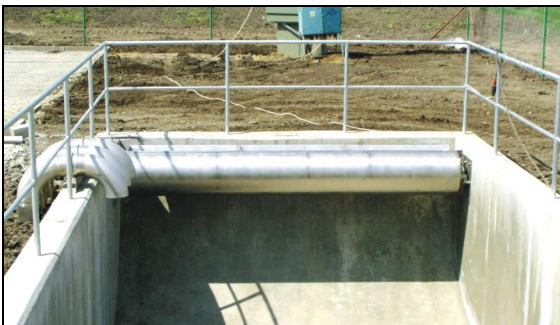
foto č. 14 Vyplachovací šachta dešťové zdrže
