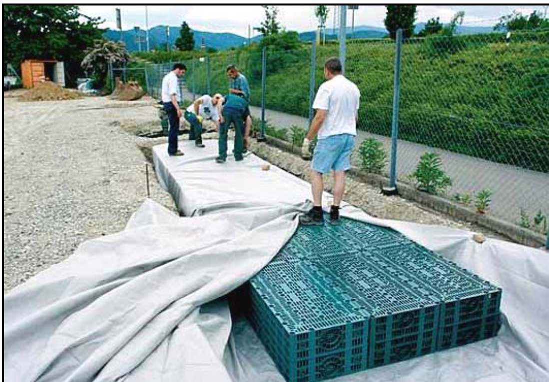
foto č. 5 Vsakovací systém pomocí plastových bloků
