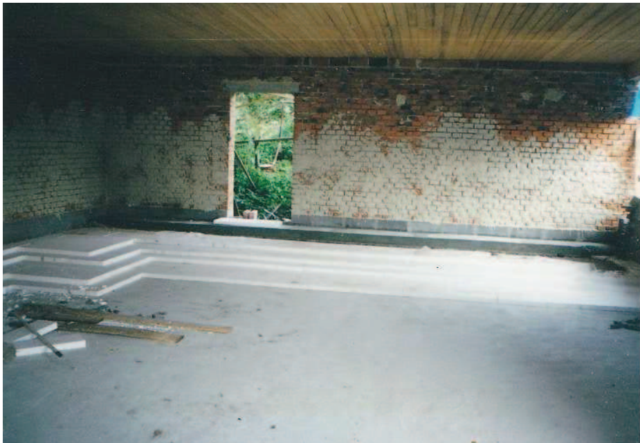
Obr. 4.6 – Tepelná izolace podlahy polystyrénem 4 x 50 mm [majitel]
