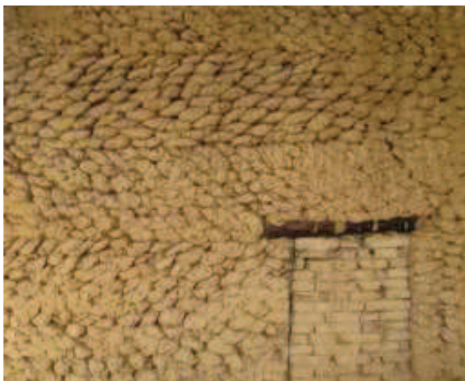
Obr. 2.6 – Zeď postavena z válků [10]
