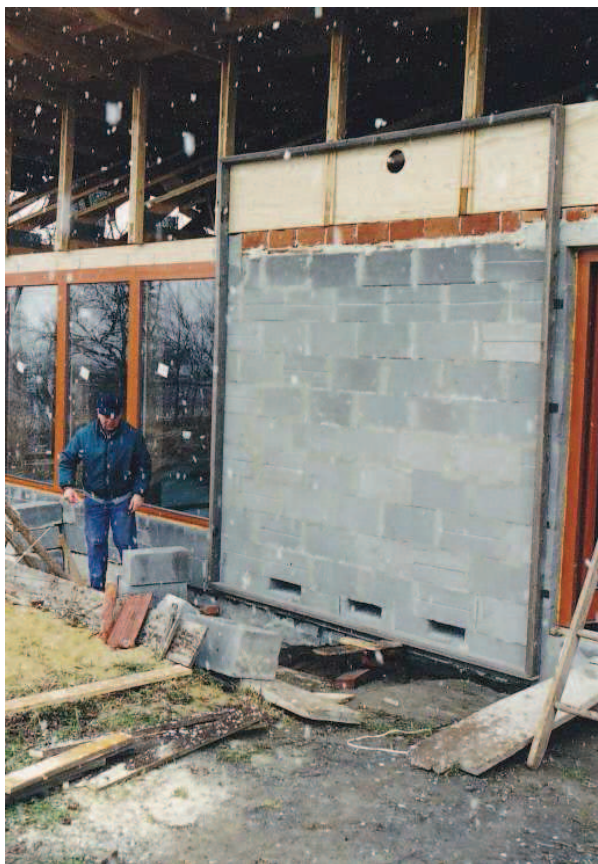
Obr .4.7 - Umístění teplovzdušného kolektoru [majitel]
