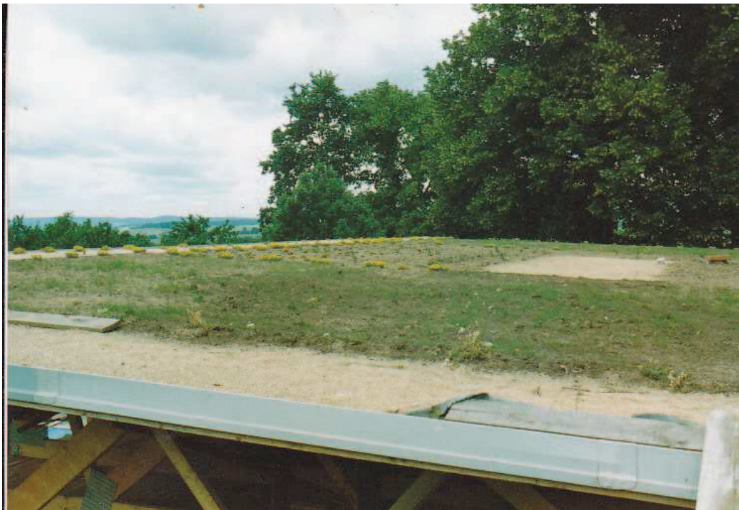
Obr. 4.5 – Realizace střechy - Extenzivní zelená střecha [majitel]
