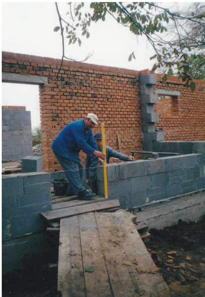
Obr. 4.3 – Výstavba RD – severní strana [majitel]
