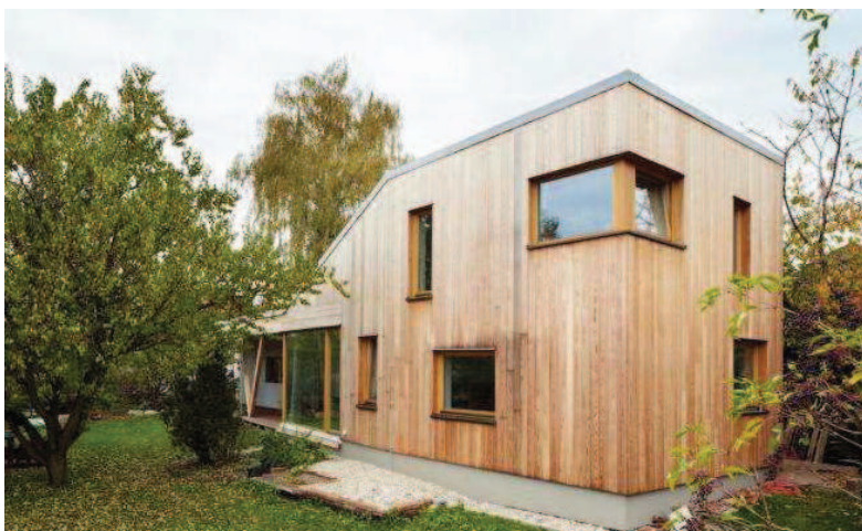
Obr. 2.9 - Dřevostavba z montovaného masivu [18]
