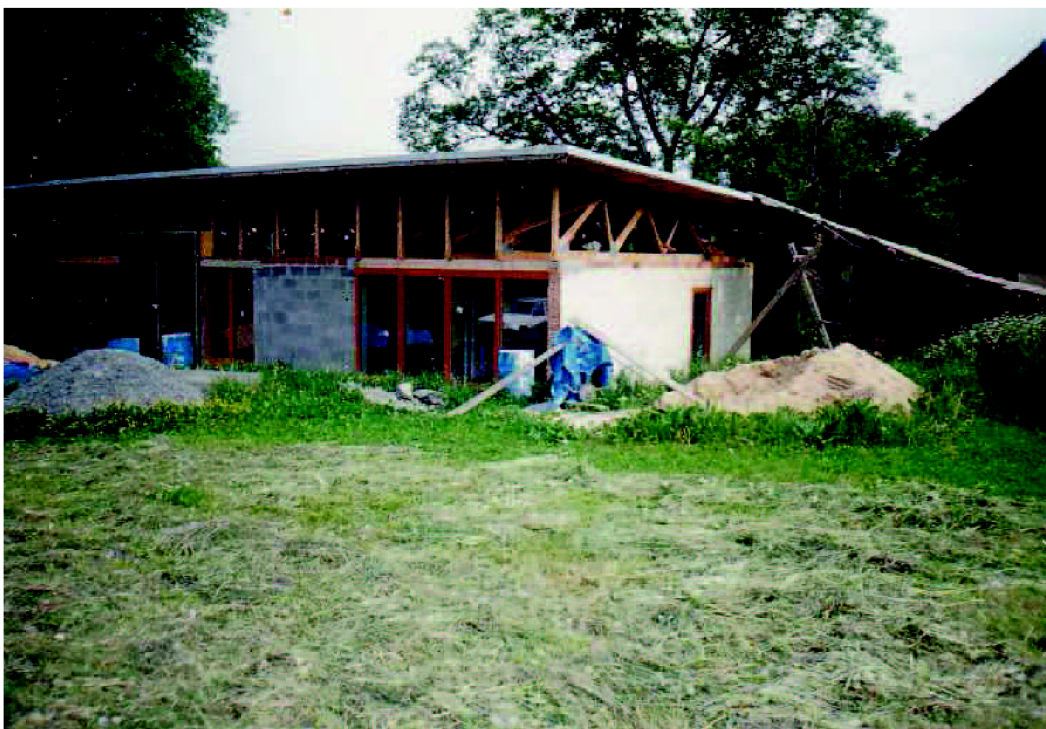
Obr. 4.4 – Výstavba RD – jižní strana [majitel]
