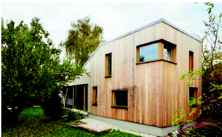
Obr. 2.9 - Dřevostavba z montovaného masivu [18]
