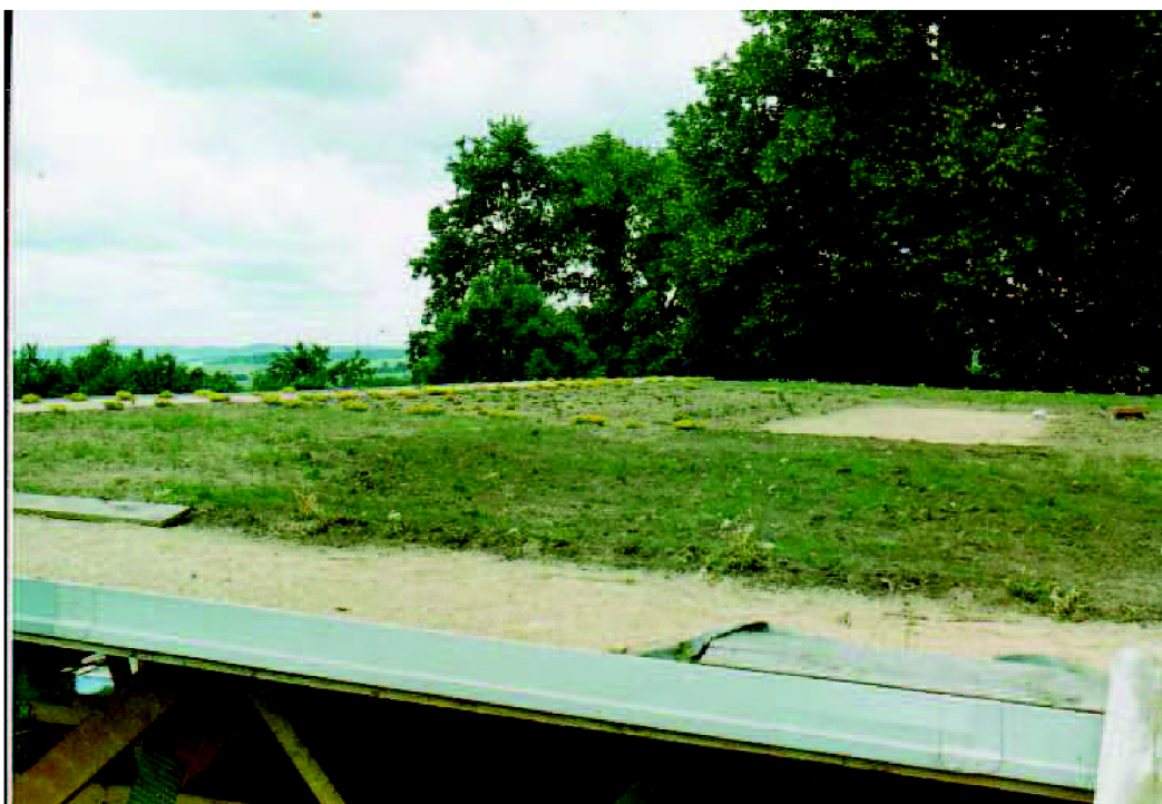
Obr. 4.5 – Realizace střechy - Extenzivní zelená střecha [majitel]
