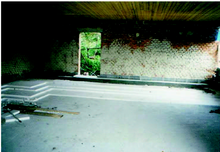
Obr. 4.6 – Tepelná izolace podlahy polystyrénem 4 x 50 mm [majitel]
