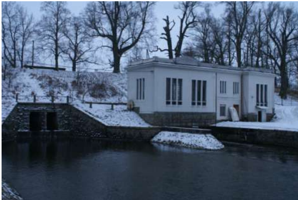
Obrázek 24 Budova vodní elektrárny s jalovou propustí
