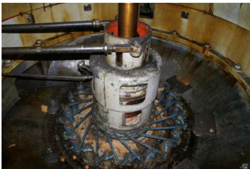
Obrázek 26 Ovládací táhla rozváděcích lopatek
