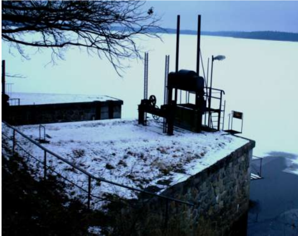
Obrázek 23 Vtokový objekt s tabulovým uzávěrem
