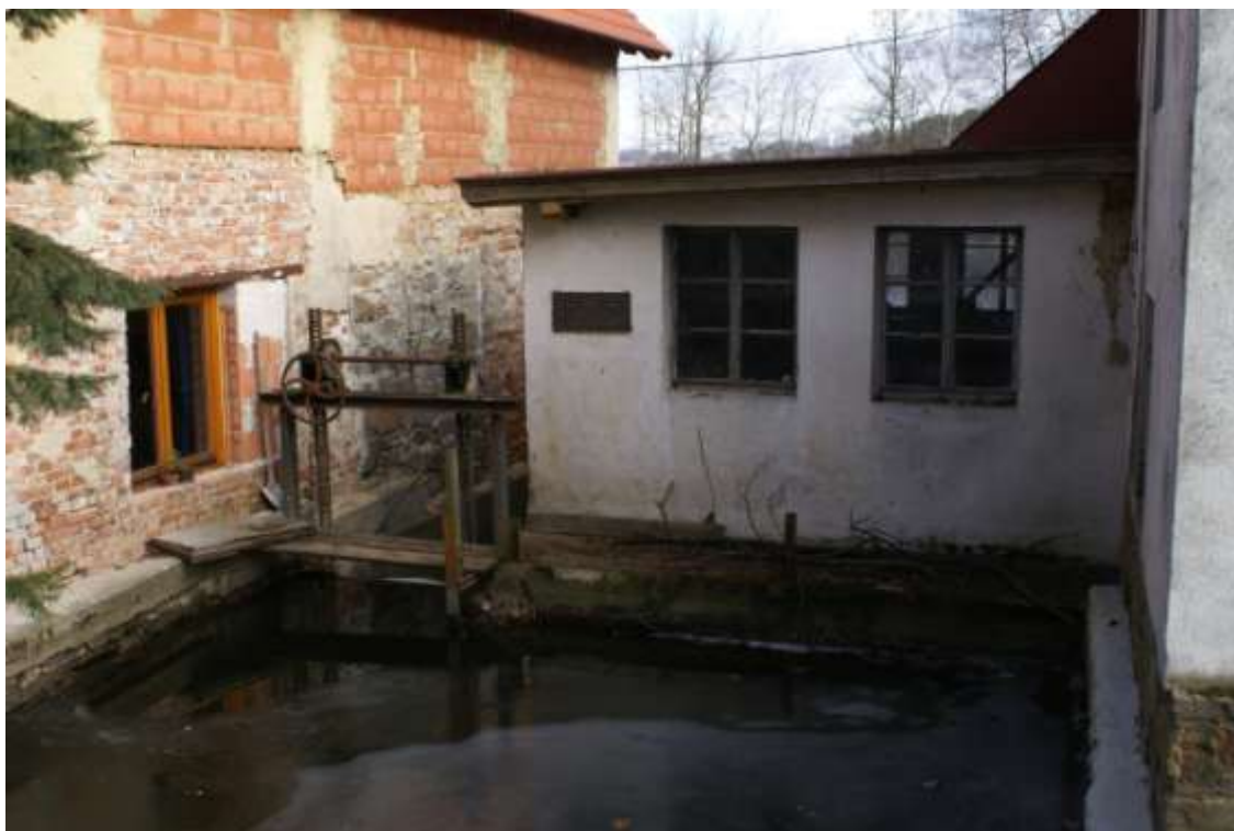
Obrázek 5 Objekt strojovny s česlemi a jalovou propustí
