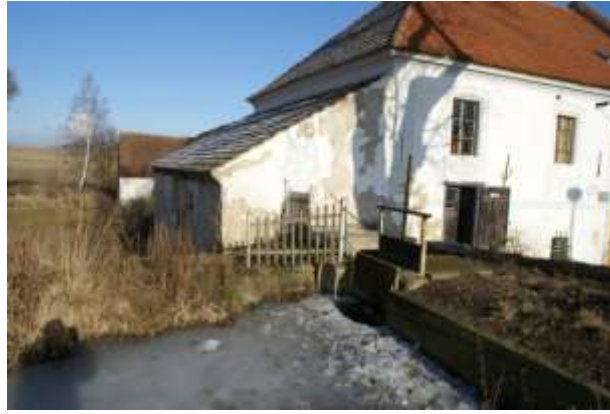
Obrázek 8 Mlýn s česlemi a uzávěrem vody
