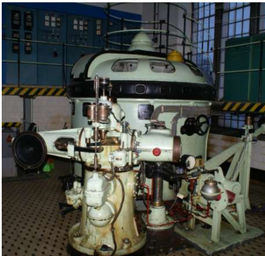
Obrázek 25 Soustrojí s regulátorem otáček
