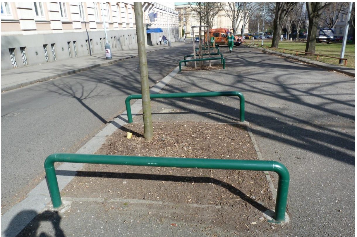
Obr. 10 ocelové zábrany, které zabránily hutnění zeminy auty.
