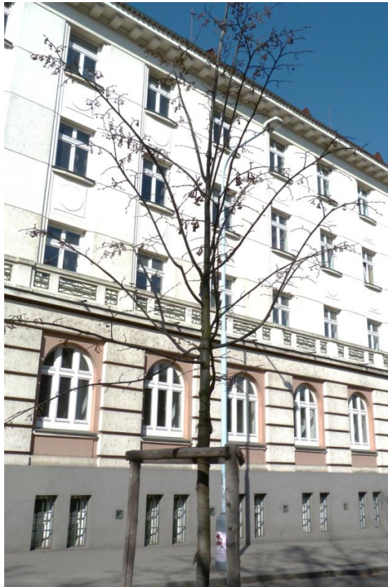
Obr. 45 patří k nové výsadbě, je zde stále konstrukce
