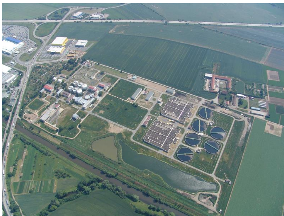
Obrázek 5 Brněnská čistírna odpadních vod v Modřicích (Brněnské vodárny a kanalizace, a.s., 2016 12 )
