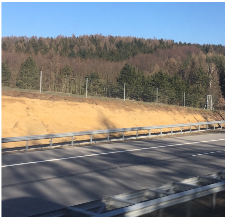
Obr. 11: Oplocení silnice (VLASTNÍ FOTOGRAFIE, 2019)
