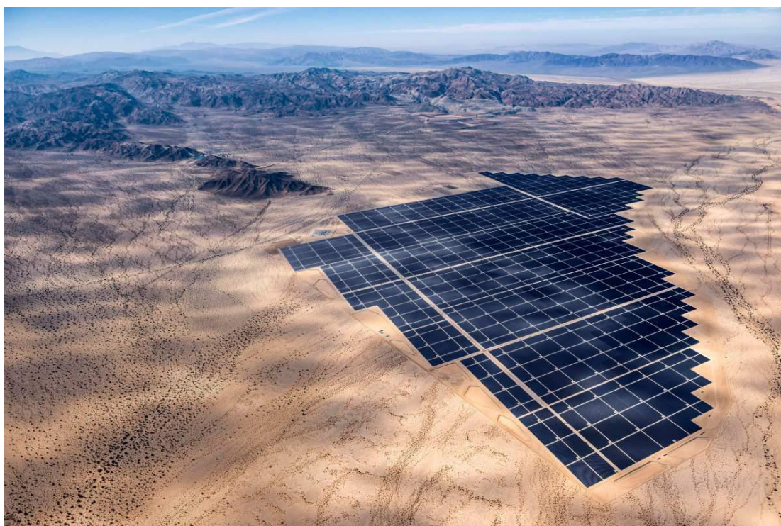
Obr. 1.7.1. Elektrárňa Desert Sunlight Solar Farm [26].
