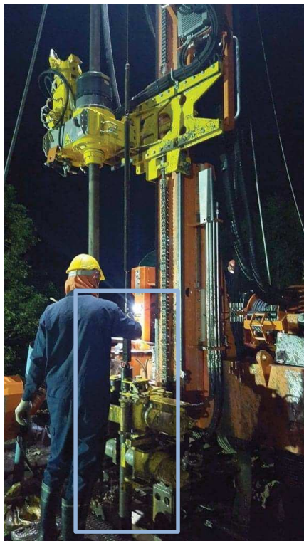
Obr. 1.7 Vrtání metodou Wireline [7]
