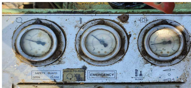
Obr. 2.1 Nastavení pracovních tlaků vrtného zařízení
