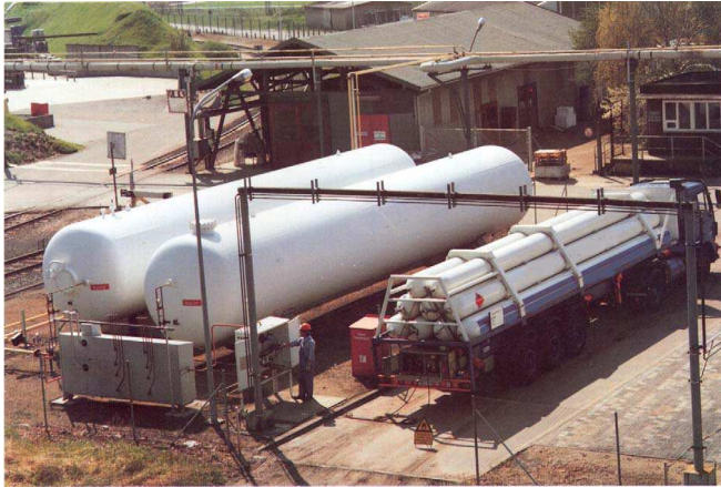
Obr.21 Skladování plynného vodíku ve velkokapacitních zásobnicích
